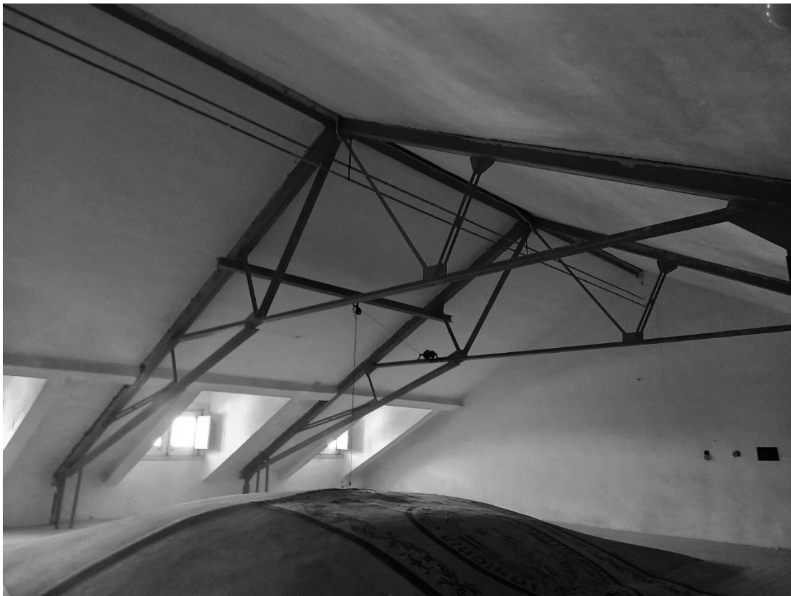
Figura 77 – Estrutura metálica de suporte da cobertura.
