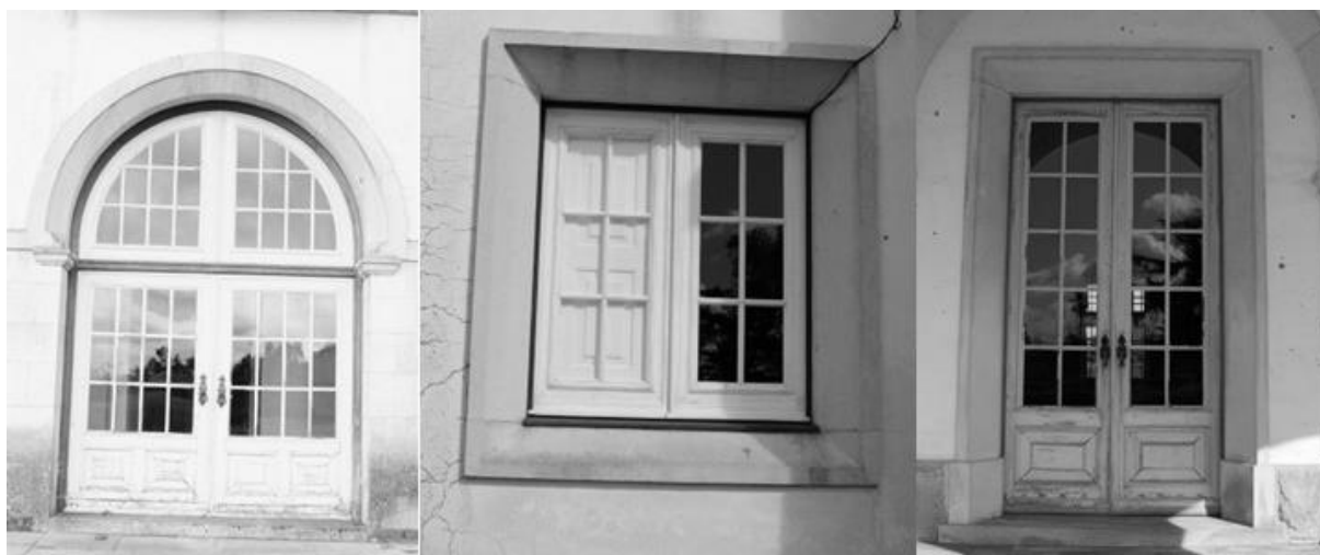
Figura 82 – Diferentes tipologias de caixilho na dimensão do objeto de estudo.
