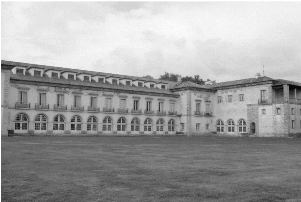
Figura 47 – Fachada tardoz (nascente) do palácio de São Marcos
