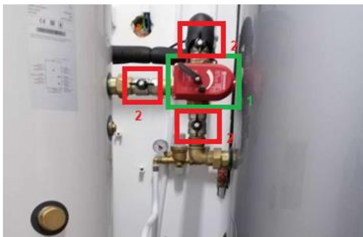
Figura 5.23. 1-Válvula de três vias, Caleffi ; 2-válvulas de corte, Caleffi .
