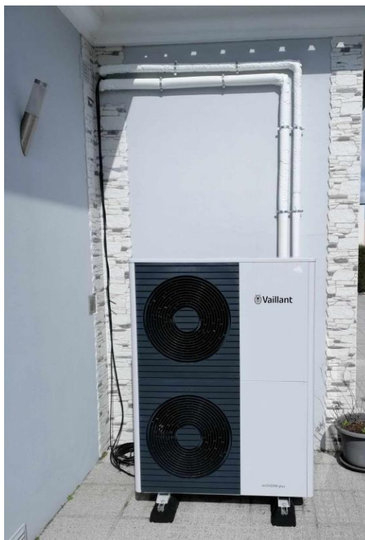
Figura 5.19. Bomba de Calor aroTHERM PLUS , da marca Vaillant .
