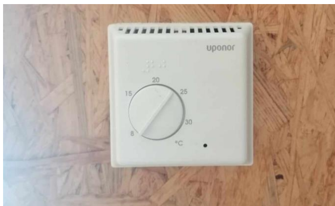
Figura 5.16. Termóstato analógico, da marca Uponor .
