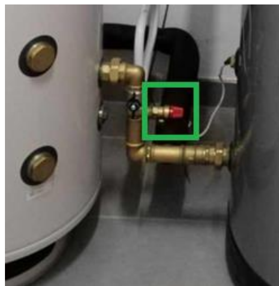
Figura 5.24. V. de segurança no depósito de AQS. Figura 5.25. V. de segurança no depósito de inércia.
