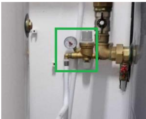
Figura 5.26. Grupo de enchimento automático, da marca Ofamat .
