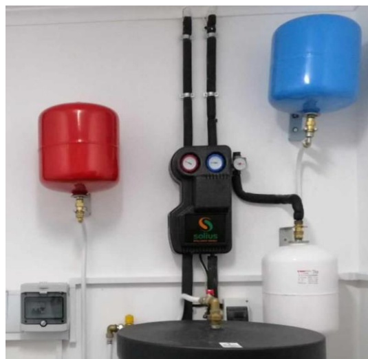
Figura 5.21. Depósito AQS, Ofamat e depósito de inércia, videira . Figura 5.22. Vasos de expansão solar, AQS e AQC, marca Reflex .
