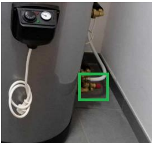
Figura 5.24. V. de segurança no depósito de AQS. Figura 5.25. V. de segurança no depósito de inércia.
