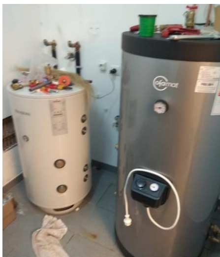
Figura 5.21. Depósito AQS, Ofamat e depósito de inércia, videira . Figura 5.22. Vasos de expansão solar, AQS e AQC, marca Reflex .
