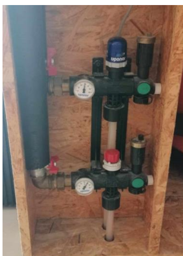
Figura 5.15. Kits coletores com o atuador e caudalímetro, marca Uponor .
