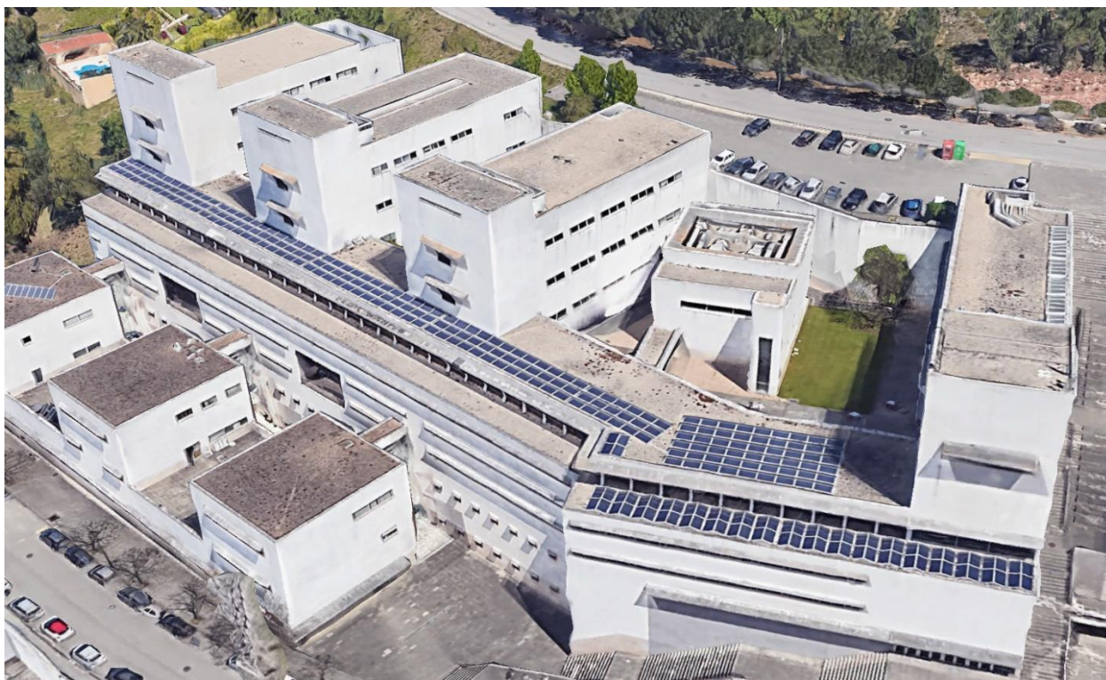
Figura 5 - Vista aérea Google Earth do DEEC, com a instalação fotovoltaica
