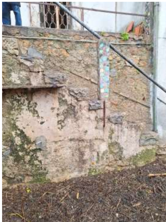
Figura 3.9 – Estado exterior, junto à fachada posterior
