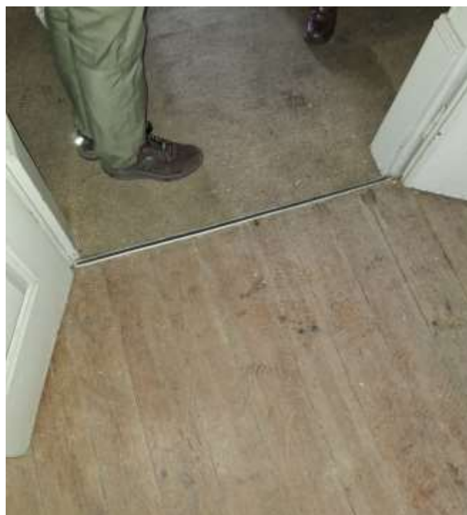
Figura 3.7 – Pavimento em madeira (e com um revestimento vinílico em cima)
