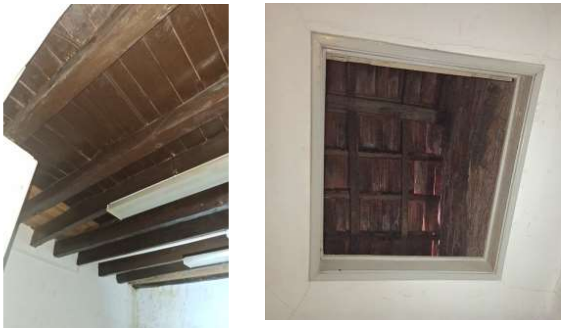
Figura 3.8 – Direção dos barrotes (esq.); Constituição da cobertura (dir.)
