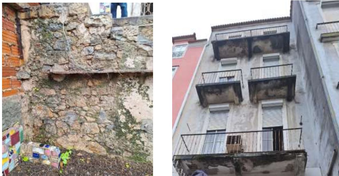
Figura 3.6 - Pedra irregular (esq.); fachada posterior (dir.)
