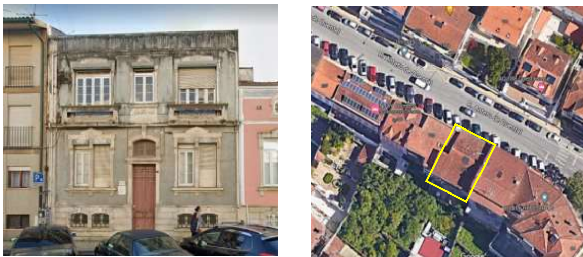
Figura 3.2 – Vista de frente do edifício em estudo (esq.); Vista de cima do edifício (dir.)
