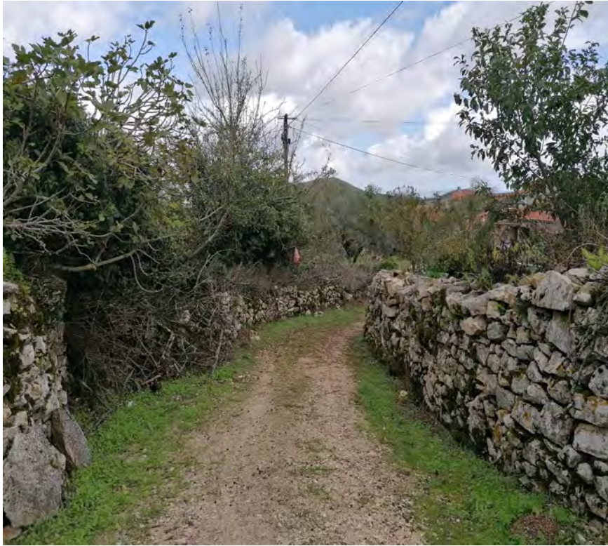
Figura 28: Muros de Pedra Seca
