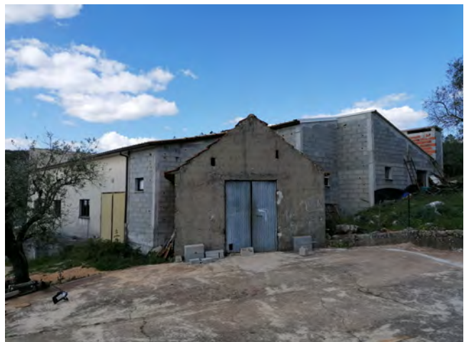
Figura 56: Casa da Eira a intervir na entrada Nascente
