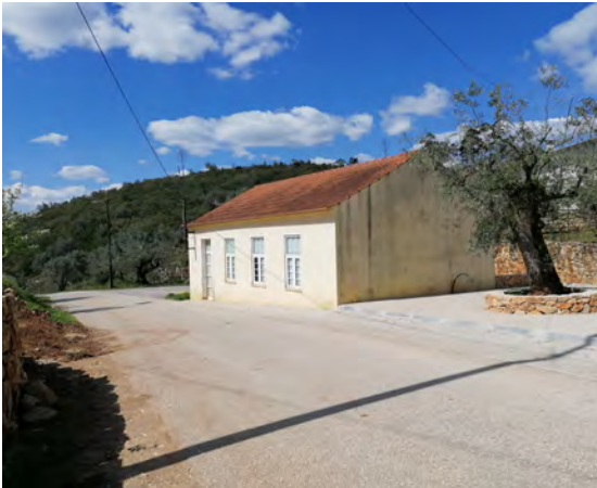
Figura 53: Edifício da antiga escola primária dos Poios
