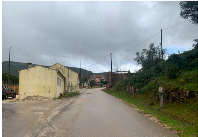
Figura 54: Edifício da antiga escola primária dos Poios
