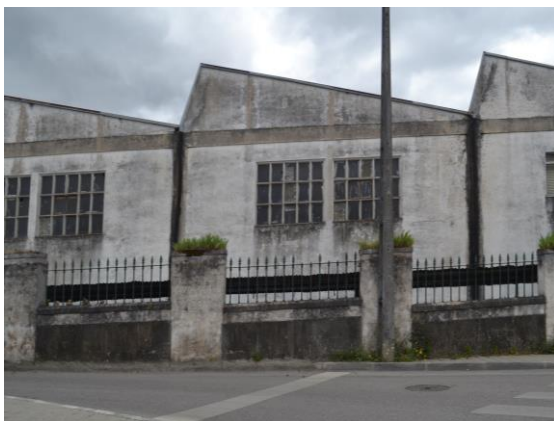
Figura 6 Vista externa da secção da fábrica com característica cobertura do tipo “shed”. Fonte: registro da autora (2023)
