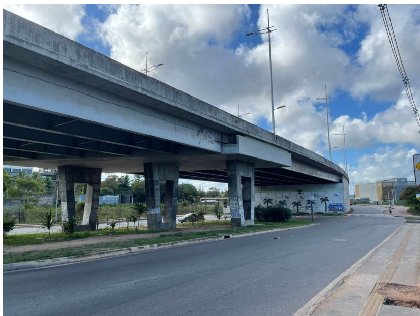
Figura 3.3 – Viaduto 1, Avenida Orlando Gomes.
