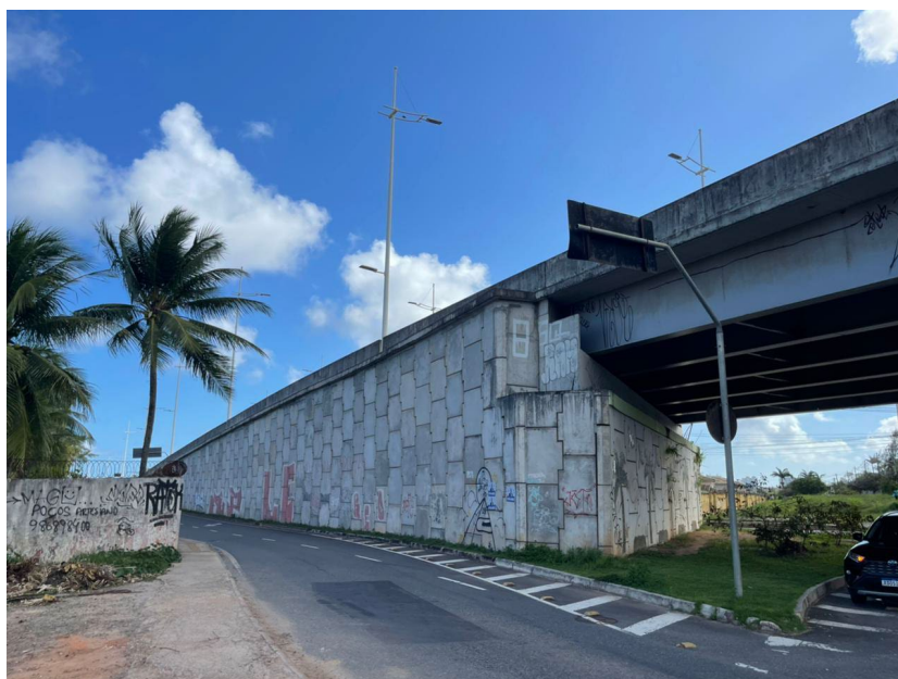
Figura 3.2 – Viaduto 1, Avenida Orlando Gomes.
