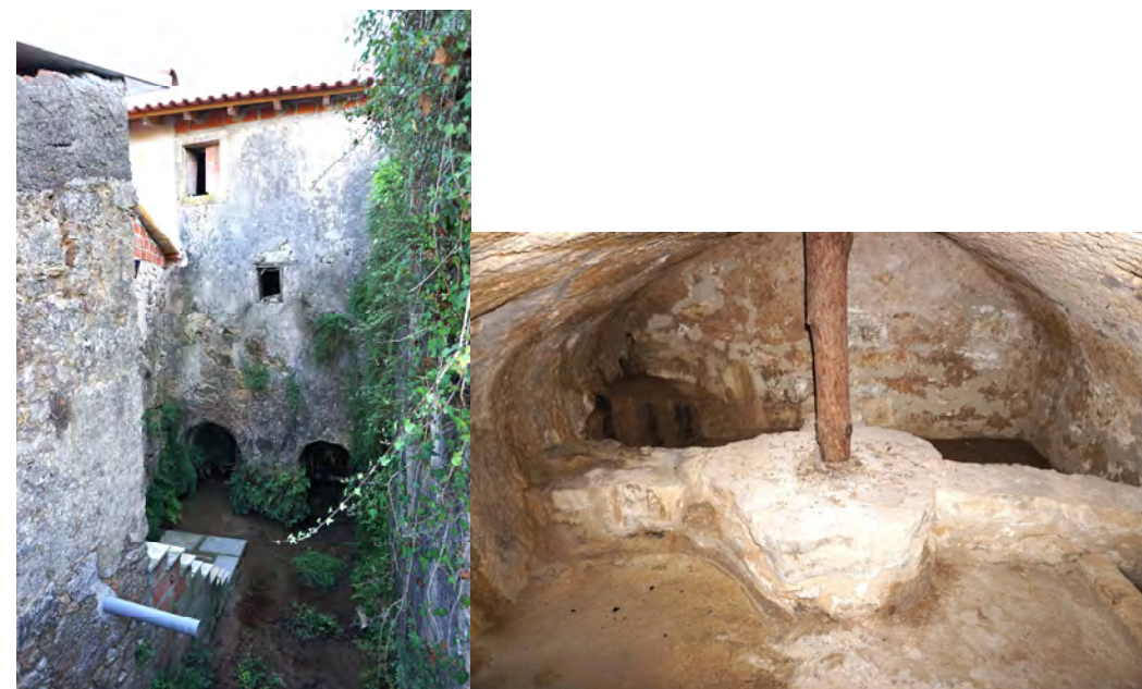
Figura 34 - Moinho e Lagar - Equipamentos de interesse público em Alcabideque
