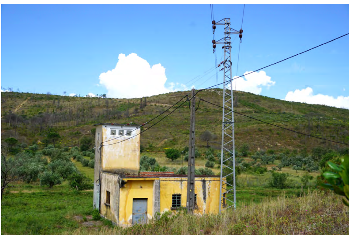
Figura 115 - Antiga estação elevatória de água - Vale da Vinha
