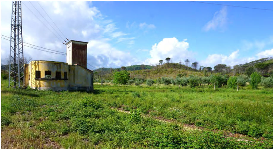
Figura 42 - Antiga Estação Elevatória de água, visita pelo exterior
