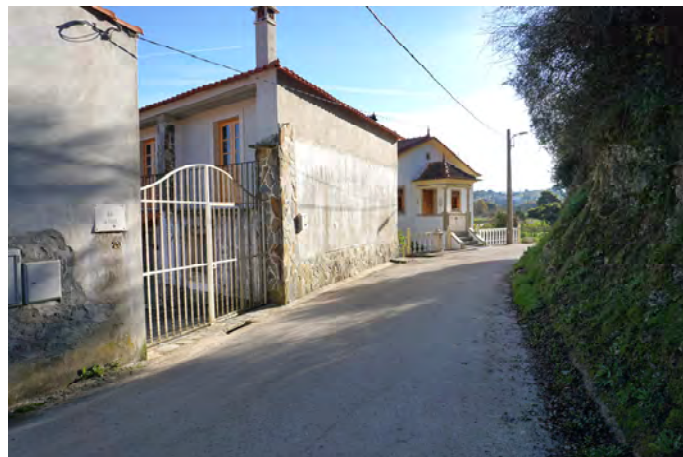
Figura 95 - Alteração de cercas, demolição e reabilitação com novos materiais
