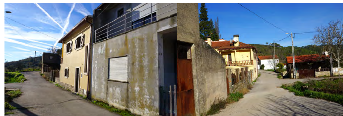
Figura 102 - Edificado a reabilitar situado a Sul do Antigo Moinho e Lagar
