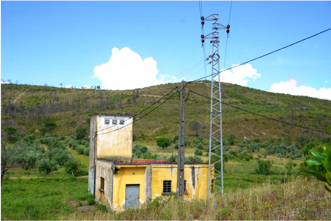
Figura 125 - Vista da Estação elevatória de água sobre o monte serra da Ponte
