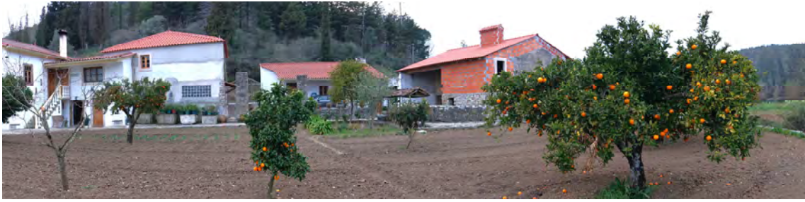
Figura 93 - Edifício a reabilitar - Antigo moinho e lagar
