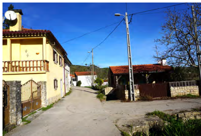
Figura 52 - Edifício local a reabilitar
