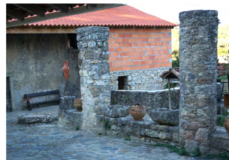
Figura 109 - Materialidade existente exterior - parte a manter - muros e pilares
