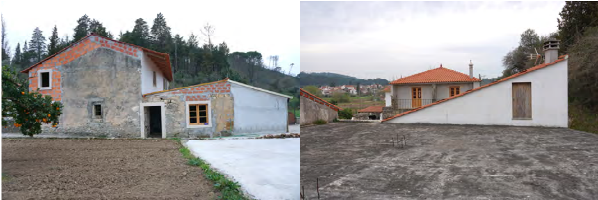
Figura 92 - Edifício degradado e mal intervencionado - Antigo Moinho
