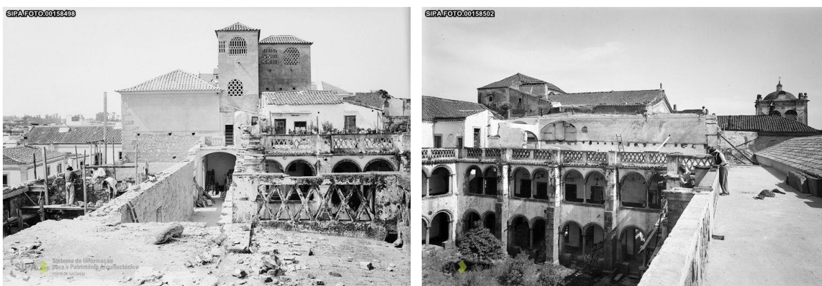
Fig. 2.11. Aspeto das obras de reconstrução na ala do convento voltada à Rua de Santa, incluindo da galeria do claustro (Fotografia: DGPC, SIPA, 1942); Fig. 2.12. Aspeto das obras já terminadas na ala poente, sendo iniciadas demolições na ala sul (Fotografia: DGPC, SIPA, 1943)
