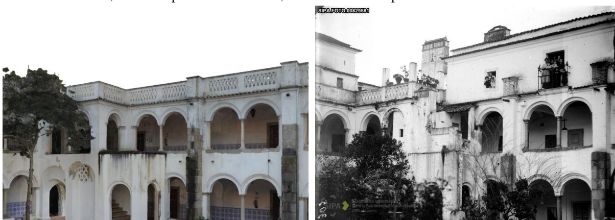
Fig. 6.4. Perspetiva do claustro, emulada no modelo de superfície, de fotografia do arquivo da DGPC, SIPA, de 1936, permitindo confronto direto e assim ilustrando modificações havidas
