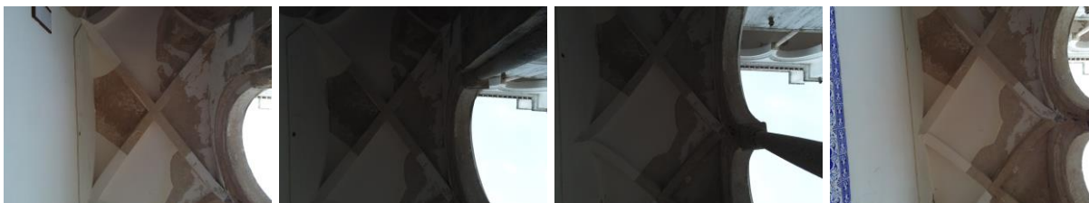
Uma sequência malsucedida – efeito de paralaxe pronunciado, fortes contrastes de zonas de sombra interiores e zonas exteriores iluminadas
