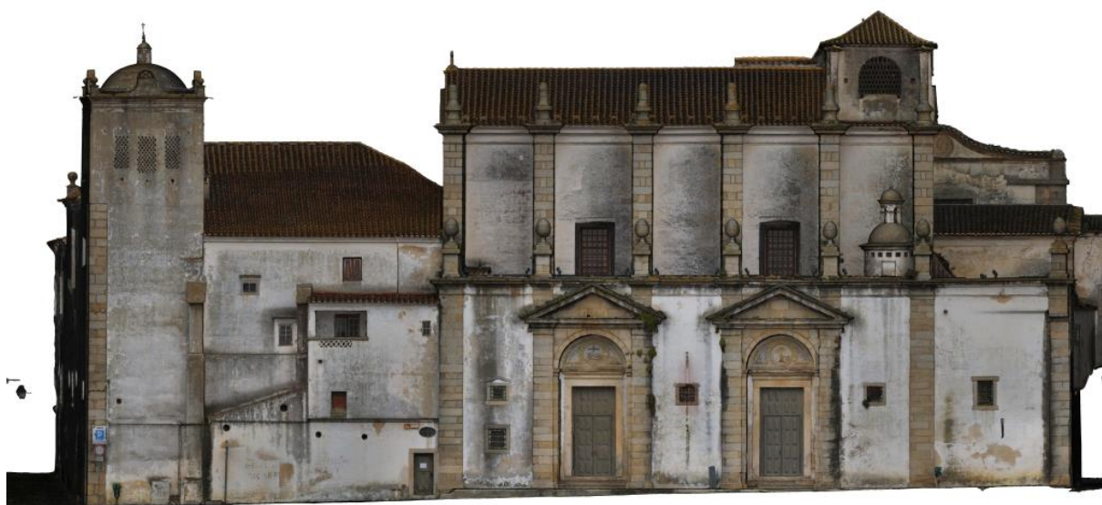
Fig. 4.6. Ortoimagem – alçado sul da igreja, em resultado da reconstrução e obtido do CC
