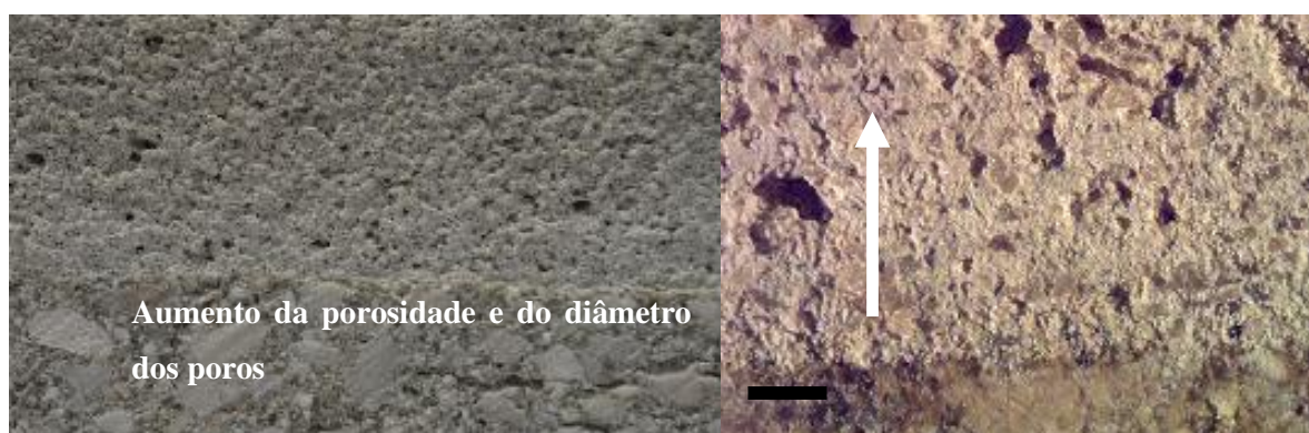
Figura 4.18 Argamassa aplicada na placa de betão - (dir.) Fotografia, (esq.) Lupa estereoscópica (barra: 1mm)
