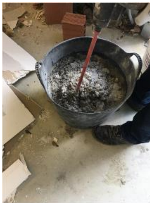
Figura 3.7 Preparação da argamassa
