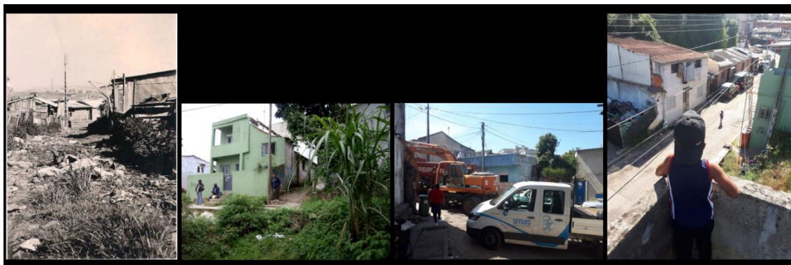
Figure 6 - Rabulera 1978 (Álvaro Silva); Rabulera 2015 (Pedro Varela); House demolitions in Rabulera 2021 (Pedro Varela); Rabulera 2021 (Pedro Varela).
