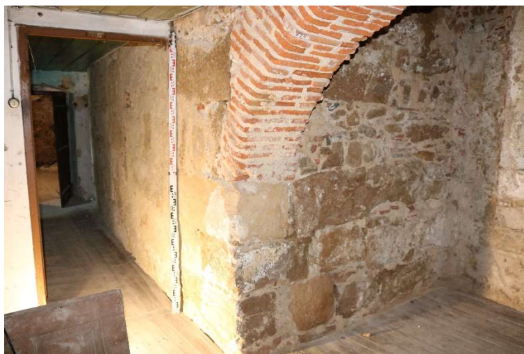
fig. 60 e 61. casa das Talhas detalhe de vão com verga manuelina, exposto já emparedado, piso 1 (em cima) detalhe de torreão, piso – 1 (em baixo) fotografias do autor, 2018
