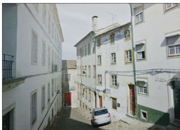
perspetiva nordeste sobre a rua do Norte (edifício reabilitado ao centro, antes da reabilitação)
