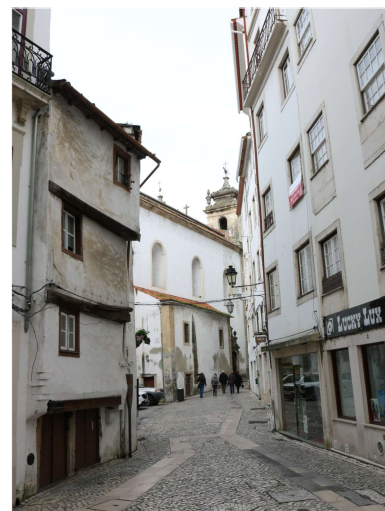
perspetiva geral do imóvel no seu contexto urbano
