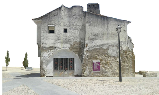
perspetiva oeste (antes da intervenção)
