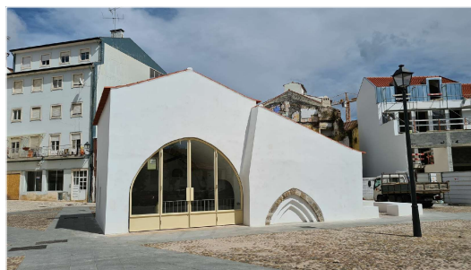
perspetiva oeste (após a intervenção)
