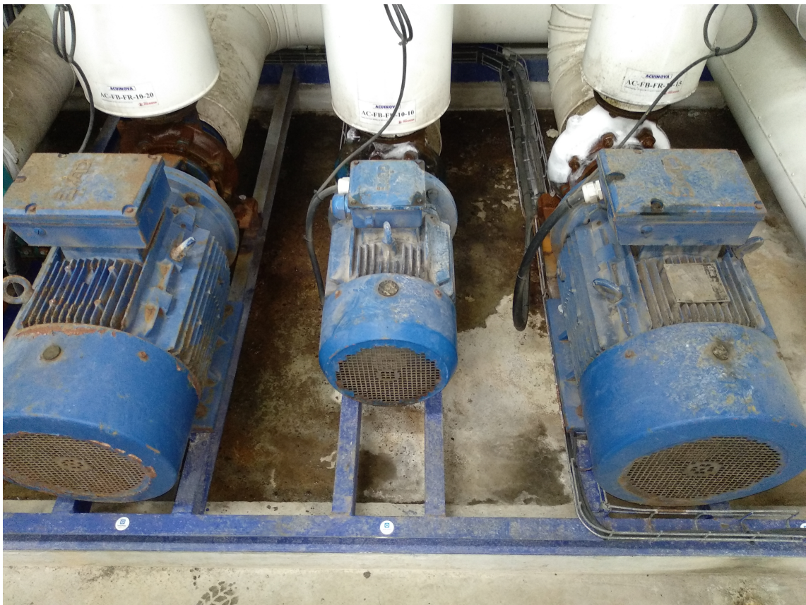
Figura 5.15: Bombas em meio industrial de aquacultura responsáveis pelo controlo de temperatura da água em tanques de desenvolvimento de peixe.
