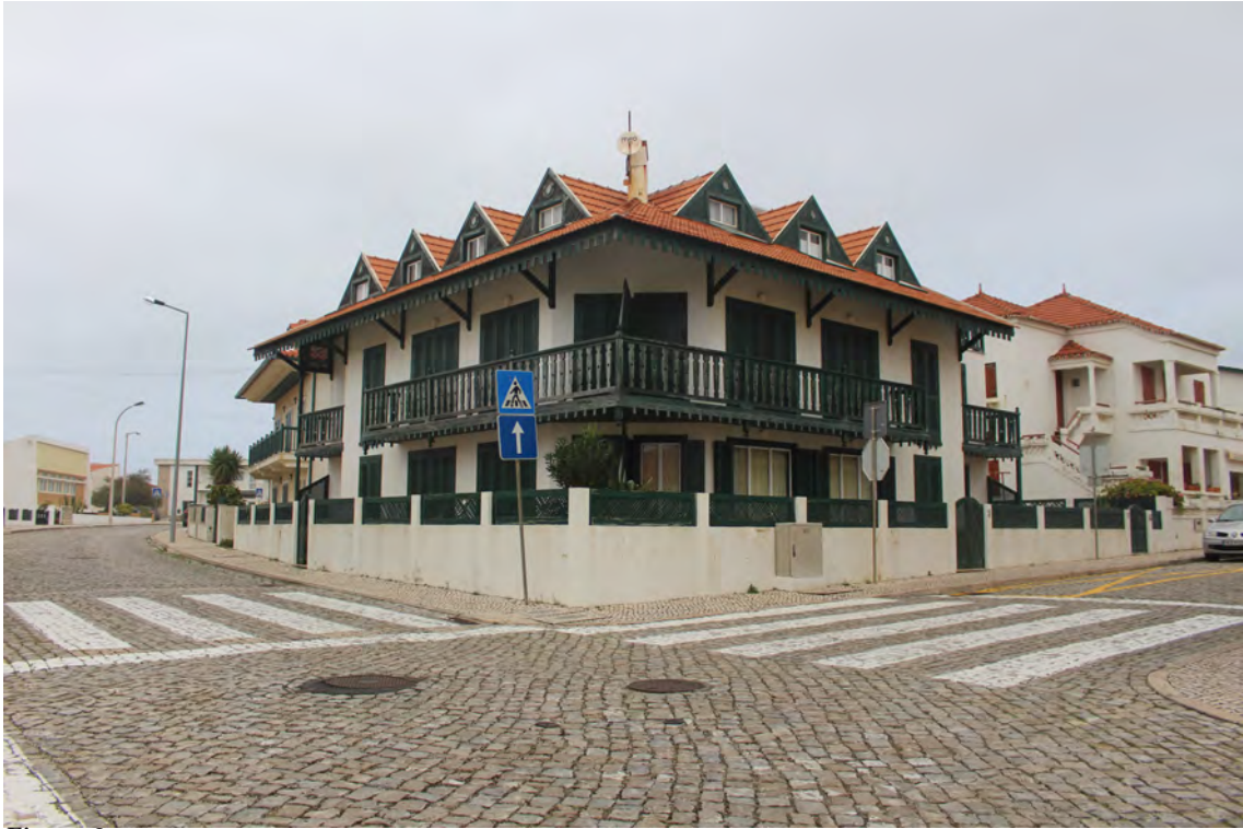
Figura 8 - Casa de Praia de São Pedro de Moel
