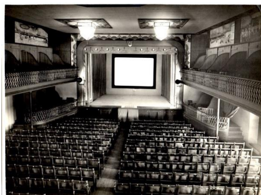
Figura 12 D. Vista do interior do Grupo Caras Direitas Fonte: Arquivo Fotográfico do Município da Figueira da Foz
