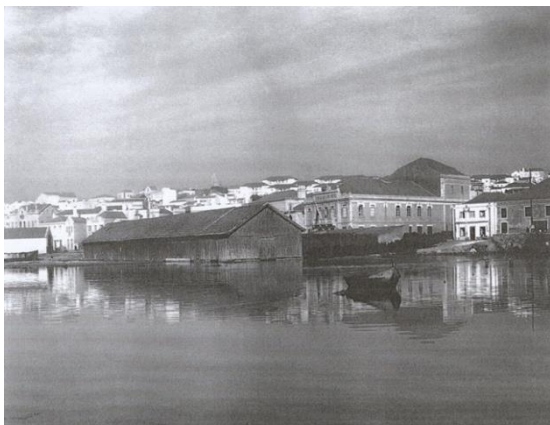
Figura 12 C. Vista do edifício do Grupo Caras Direitas em Buarcos Fonte: Arquivo Fotográfico do Município da Figueira da Foz
