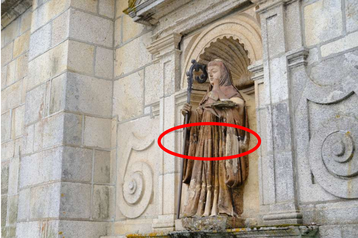
Fig. 4 – Frei Cipriano da Cruz. Santa Escolástica (pormenor a evidenciar a divisão de taelos e vestígios da argamassa de cal e areia). Frontispício da igreja do Mosteiro de São Martinho de Tibães. Fonte: Mariana Gaspar
