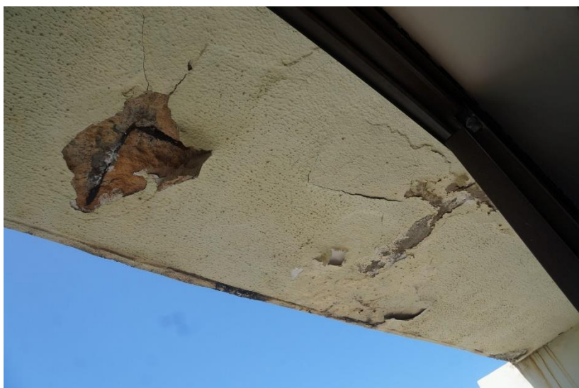
Figura 5.6 – Exemplo de viga com corrosão de armadura. (Acervo técnico da Tecomat Engenharia)
