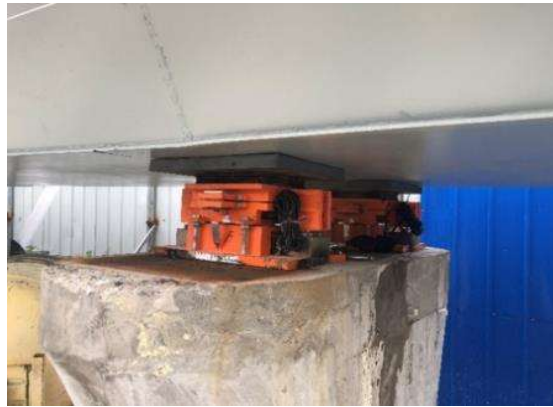
Figura 2.14– Suporte inteligente de altura ajustável (Versão final)
