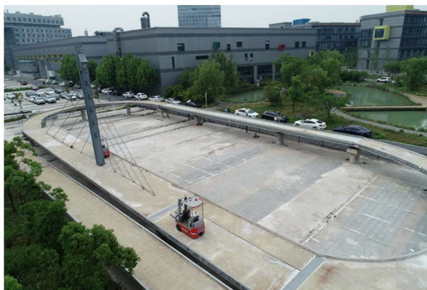
Figura 2.8– Plataforma do modelo da ponte (1).
