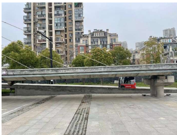
Figura 2.9– Plataforma do modelo da ponte (2).
