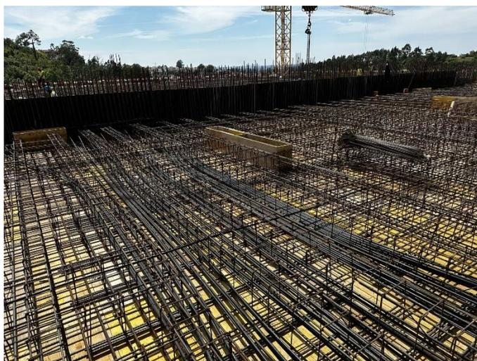
Figura 1.1 - Cordões de pré-esforço introduzidos na laje do edifício da UC Biomed em Coimbra, antes de serem tensionados
