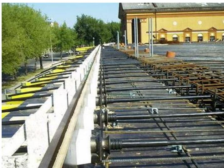
Figura 3.6 – Posicionamento de ancoragens e armaduras ativas em uma laje pós-tensionada (VSL, 2023)
