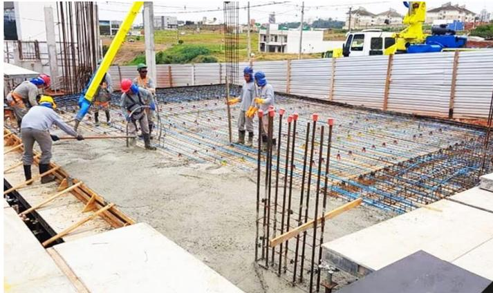
Figura 3.7 – Betonagem de uma laje pós-tensionada ([www.colunaitalo.com.br](http://www.colunaitalo.com.br))
