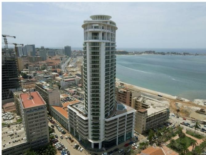
Figura 2.14 – Edifício Torre Ambiente, Luanda. Lajes executadas com pós-tensionamento utilizando monocordões não aderentes ([www.angocasa.com](http://www.angocasa.com))
