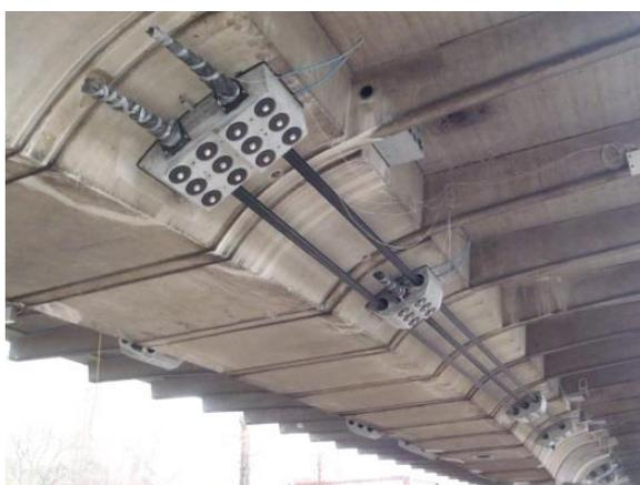
Figura 2.8 – Viaduto com aplicação de pré-esforço exterior (Freyssinet, 2023)
