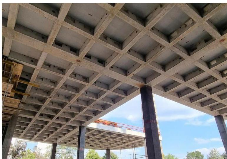
Figura 2.18 – Exemplo de edifício realizado com laje fungiforme nervurada
