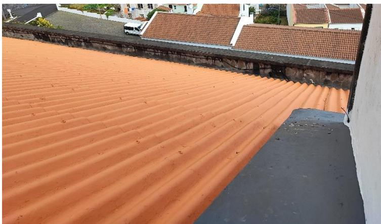
Figura 28 - Cobertura em telha fibrocimento
