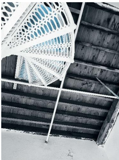
Figura 3.27. Tirantes na torre sineira.
