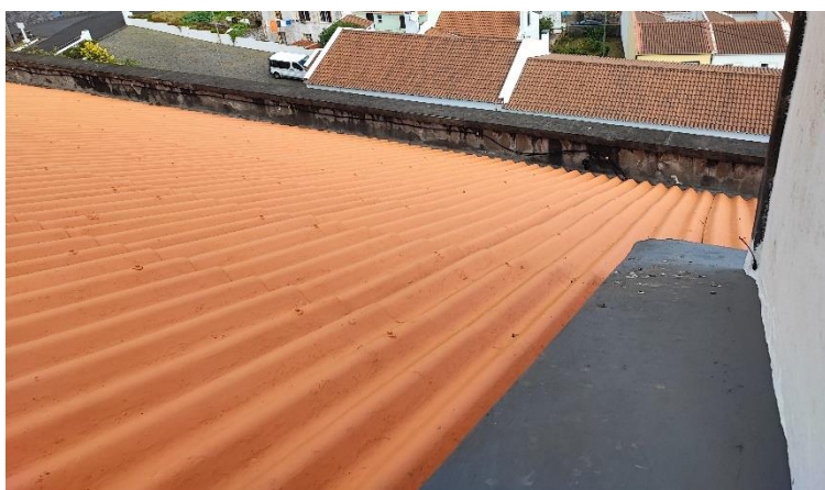
Figura 3.30. Cobertura em telha fibrocimento.
