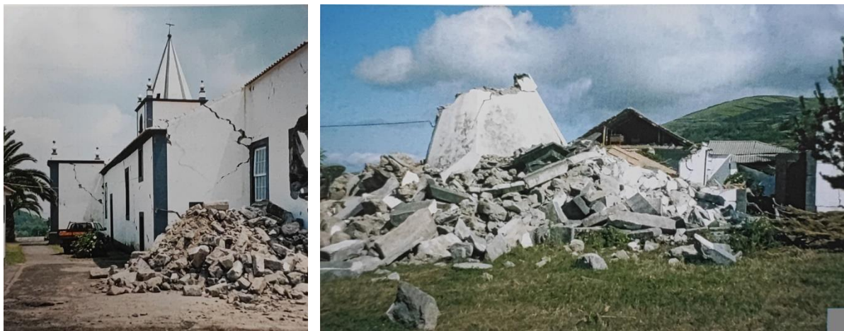
Figura 2.5. Danos em paredes e colapso total em igrejas da ilha do Faial (adaptado de (Azevedo & Guerreiro, 2008)). Figura lado esquerdo: Quase colapso por rotura das paredes por corte (mecanismo 13) da igreja de Pedro Miguel; Figura lado direito: Colapso total da igreja de Salão.
