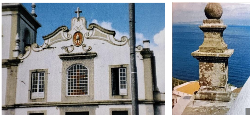
Figura 2.14. Danos em frontispícios (adaptado de (Azevedo & Guerreiro, 2008)). Lado esquerdo: Igreja de Flamengos na ilha do Faial; Lado direito: Pináculo da igreja Matriz na Horta (Faial).
