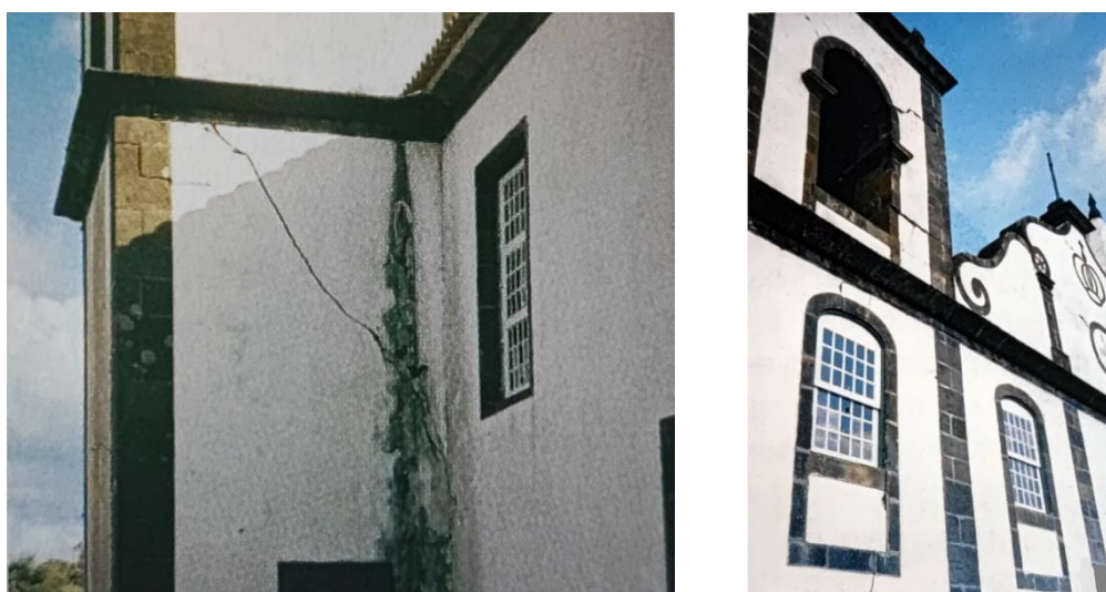
Figura 2.15. Fendilhação na torre da Igreja de Bandeiras na ilha do Pico: Imagem esquerda adaptado de (Arêde, et al., 2008); imagem da direita adaptado de (Azevedo & Guerreiro, 2008).
