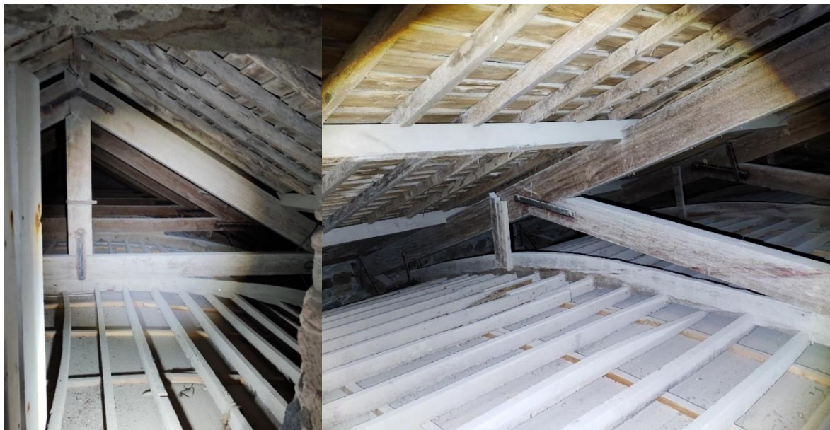
Figura 3.29. Estrutura da cobertura e desvão.
