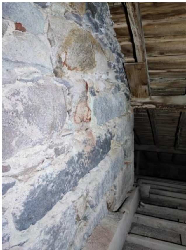
Figura 3.28. Foto da parede norte da torre sineira no desvão da cobertura.
