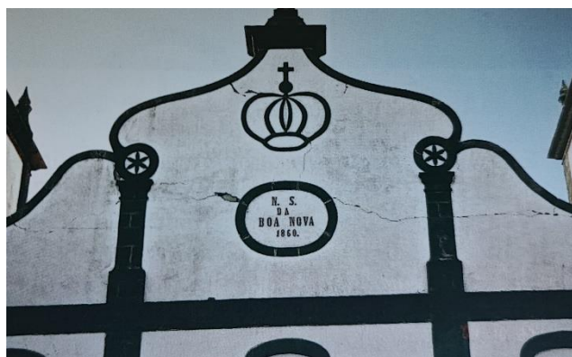
Figura 2.13 - Danos no frontão da igreja de Bandeiras na ilha do Pico (adaptado de (Arêde, et al., 2008)).
