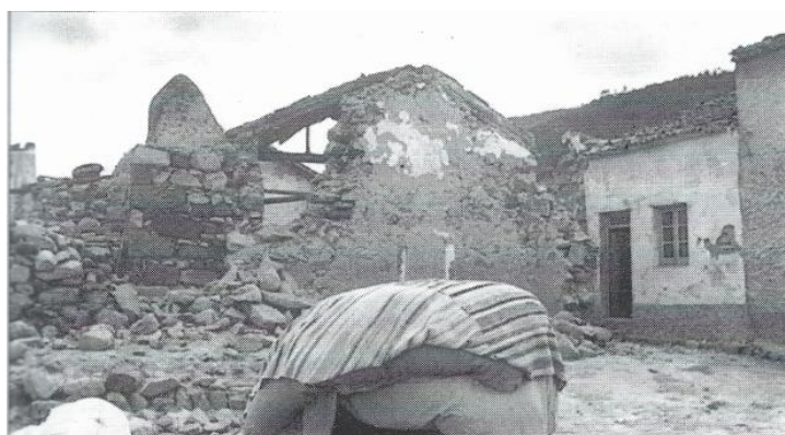
Figura 3.15. Imagem do abalo sísmico de 1932: edifício colapsado pelo sismo (adaptado de (Jerónimo, 1998)).
