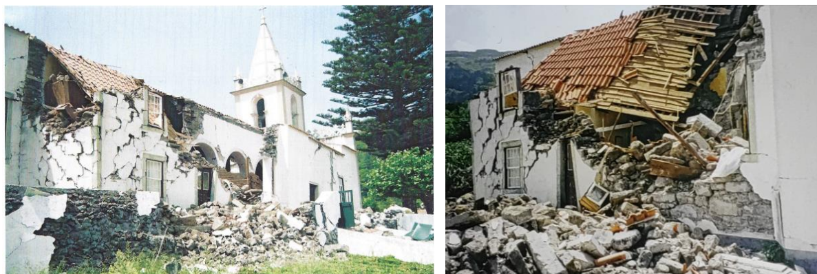
Figura 2.4. Colapso da nave lateral, da igreja da Ribeirinha, devido ao movimento da parede exterior para fora do seu plano (adaptado de (Azevedo & Guerreiro, 2008)).
