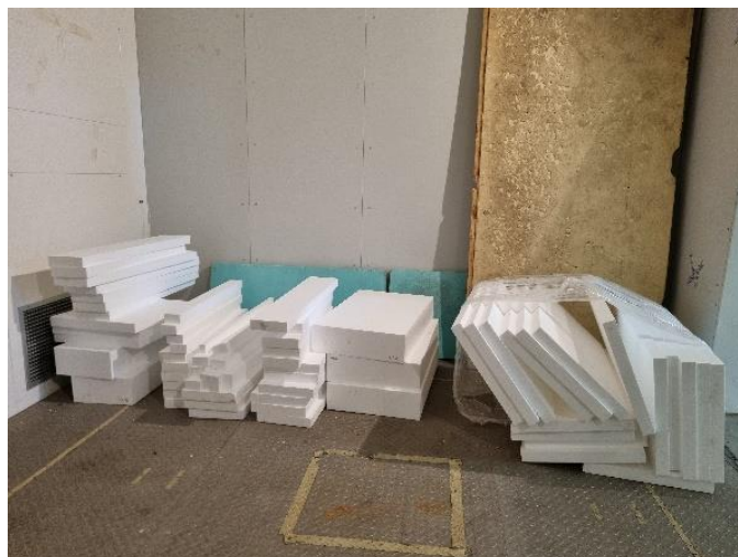
Figura 4.2. Pré-montagem das paredes.
