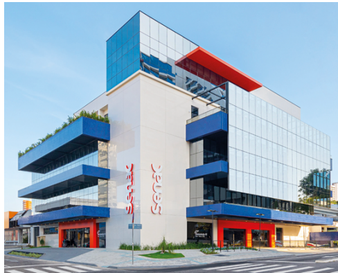
Figura 2. Edificação após a reabilitação - https://www.revistaambientesc.com.br/2020/01/29/senac-reference
