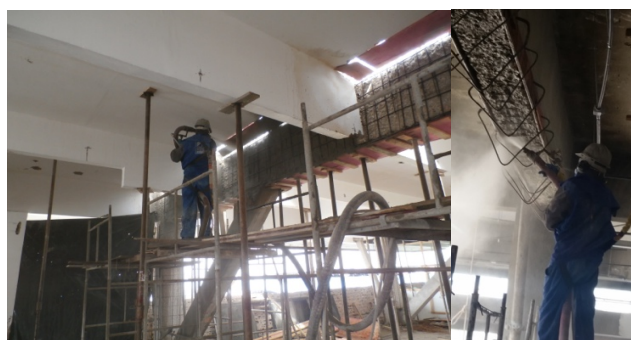
Figura 30. Concreto projetado em vigas - Modulo Engenharia
