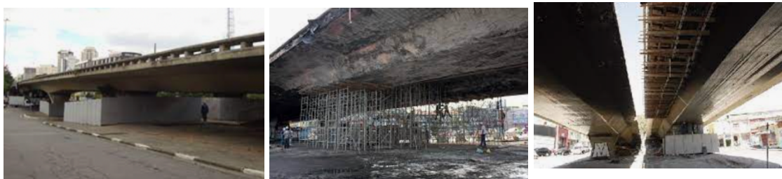
Figura 10. Reforço estrutural do viaduto Santo Amaro com utilização de compósitos em fibra de carbono - Planoengenharia
