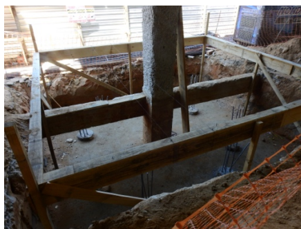
Figura 28. Arrasamento das estacas e nivelamento do fundo do bloco - Modulo Engenharia
