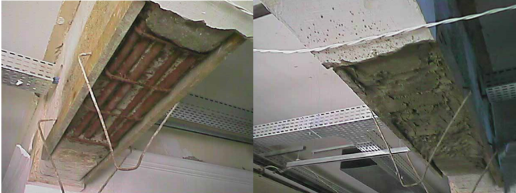
Figura 33. Regularização da superfície (Argamassa polimérica para reparo estrutural) - Modulo Engenharia
