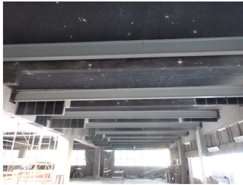
Figura 31. Reforço da laje com perfil metálico - Modulo Engenharia
