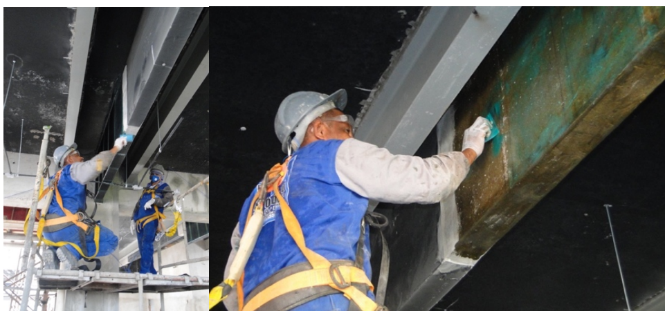
Figura 38. Aplicação da primeira camada de saturante - Modulo Engenharia
