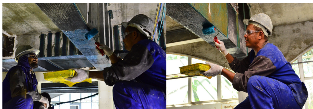
Figura 41. Aplicação da segunda camada de saturante - Modulo Engenharia
