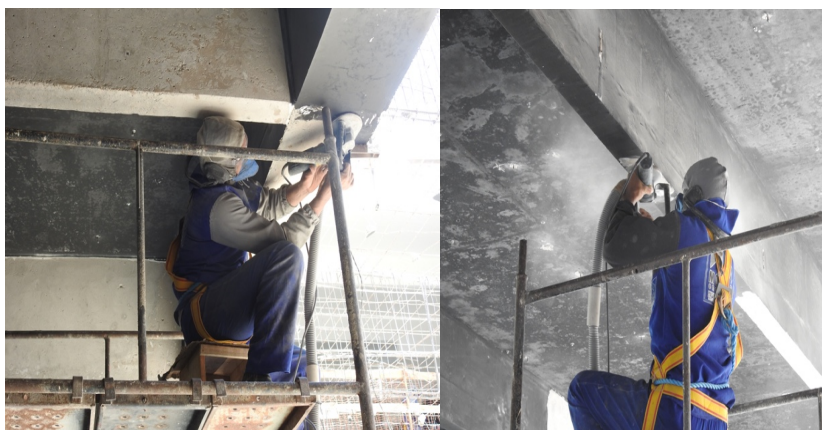
Figura 35. Preparação da estrutura (Lixamento) - Modulo Engenharia
