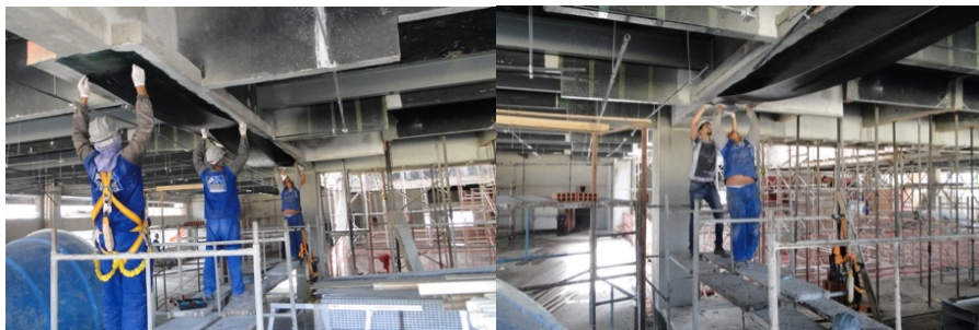
Figura 32. Colagem da fibra - Modulo Engenharia
