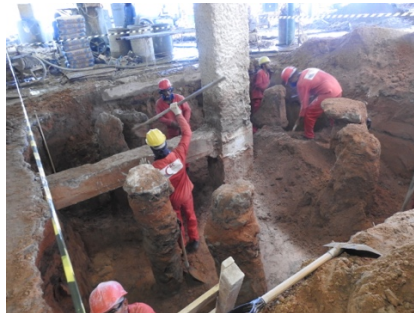
Figura 27. Estaca Raiz - Modulo Engenharia – Reabilitação Senac.
