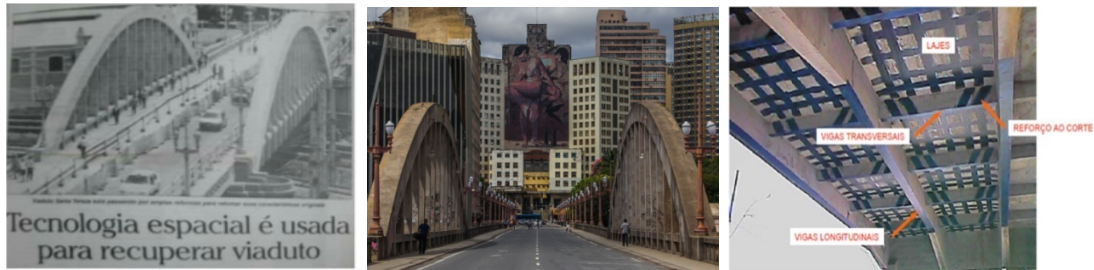
Figura 9. Reforço estrutural do viaduto Santa Tereza com utilização de compósitos em fibra de carbono - Machado (2007,p.80)
