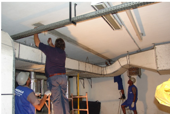
Figura 36. Marcação dos locais onde serão aplicadas o reforço - Modulo Engenharia
