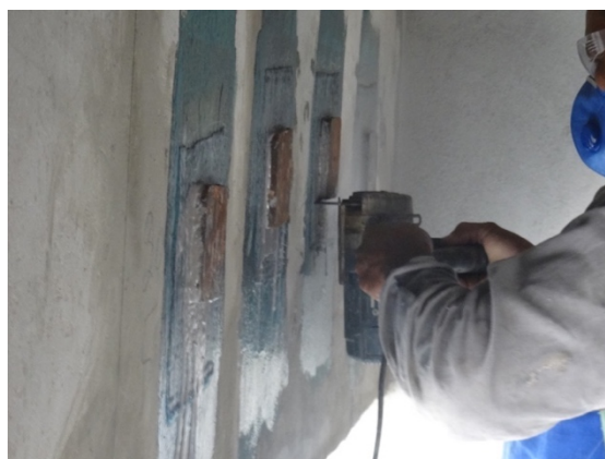
Figura 48 - Corte nos corpos de prova - Modulo Engenharia
