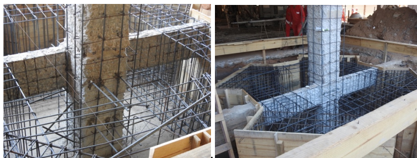
Figura 29. Montagem da forma e armadura do bloco - Modulo Engenharia
