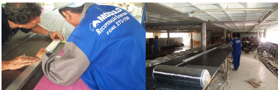
Figura 37. Marcação dos locais onde serão aplicadas o reforço - Modulo Engenharia
