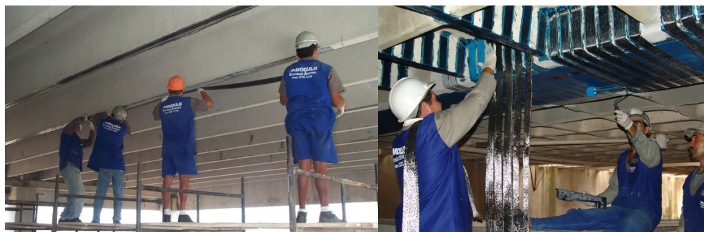
Figura 39. Aplicação da fibra de carbono - Modulo Engenharia
