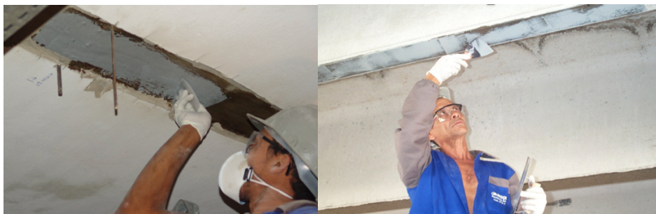
Figura 34. Regularização da superfície (Argamassa polimérica para reparo estrutural) - Modulo Engenharia
