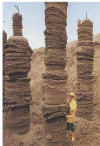
Figura 2.6.– Colunas de Jet Grouting (Correia,2016).
