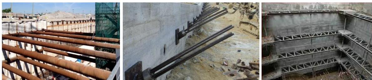
Figura 2.2.– Escoras (isherwood.to), ancoragens (www.apgeotecnia.pt) e bandas de lajes.
