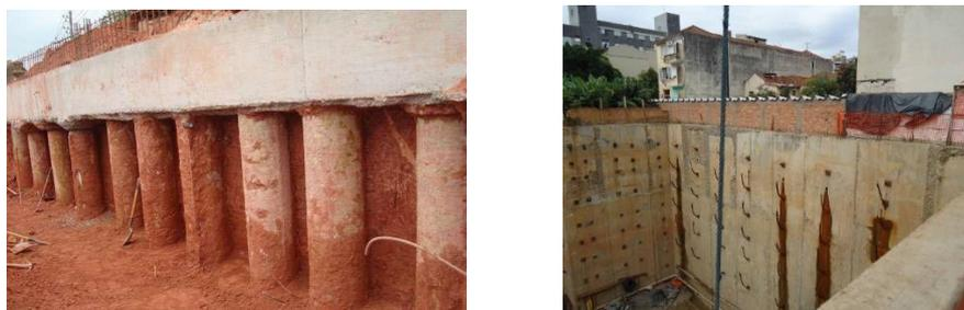
Figura 2.1.– Cortina de estacas ([www.ecivilnet.com](http://www.ecivilnet.com)) e paredes moldadas ([fabriciogonzalez.com.br](http://fabriciogonzalez.com.br)).
