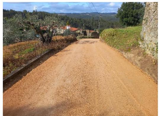
Pavimentação betuminosa – Construção de sub-base de pavimento
