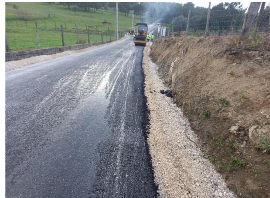
Pavimentação betuminosa – Construção camada de desgaste
