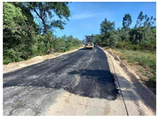
Pavimentação betuminosa – Construção camada de desgaste
