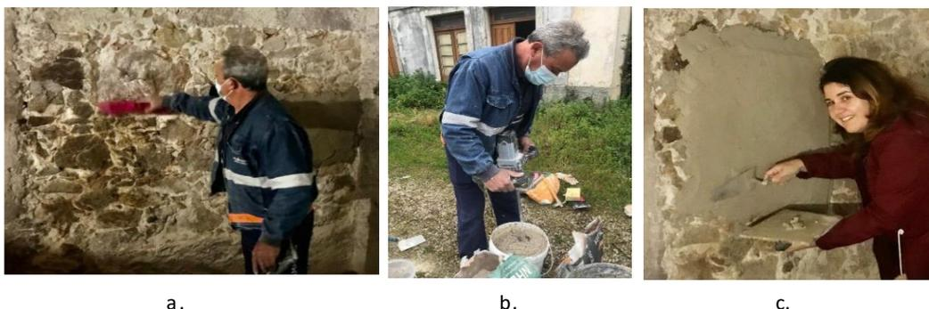
Figura 3.24 - a) Humedecendo a parede; b) Preparando a argamassa; c) Aplicando a argamassa na parede
