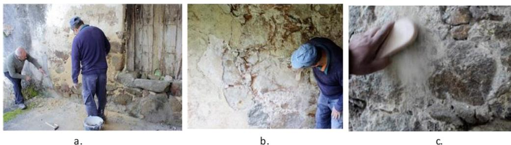
Figura 3.23- a) Retirada do Reboco; b) Limpeza dos Suportes; c) Escovagem.
