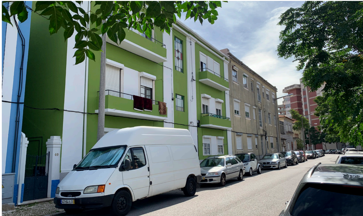
Imagem 21: Arruamento Alameda Conchada, setembro 2022, ZÁS colectivo;
