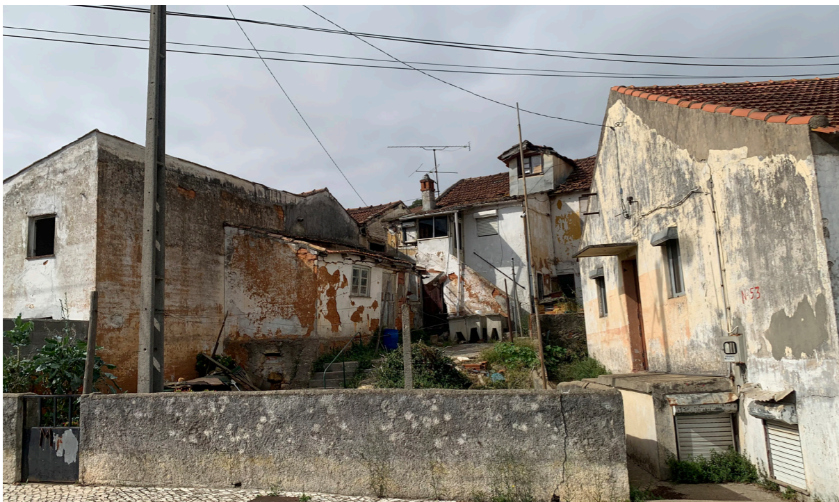
Imagem 33: Edifícios em estado de abandono na Rua Guilherme Gomes Fernandes, setembro 2022, ZÁS colectivo.
