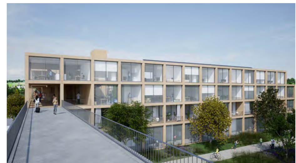
Figura 50 - Entrada pela galeria no Conjunto Norte.
