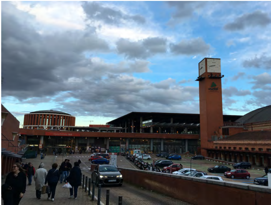
Figura 5 - Estação Ferroviária Atocha, Madrid, projeto de Rafael Moneo, 1984-1992. Fotografia da viagem de turma em Abril de 2022.
