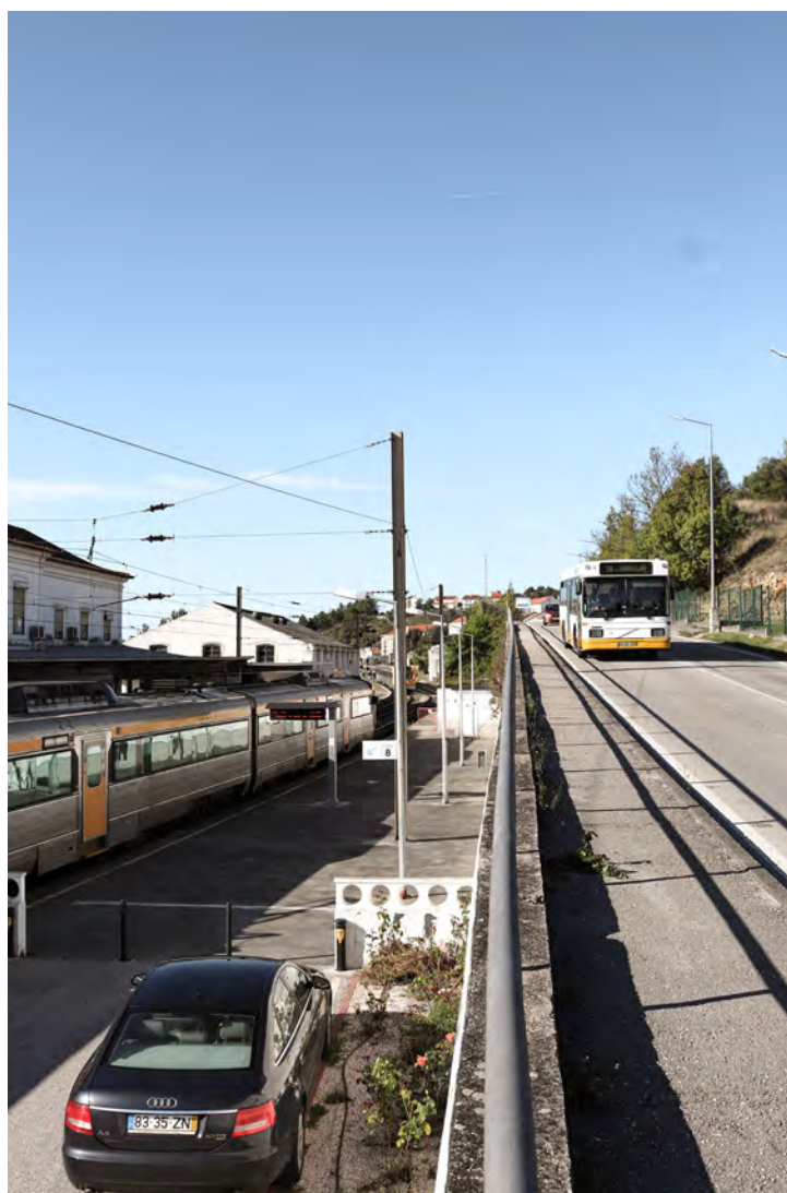
Figura 6 - Vista da atual Estação Coimbra B
