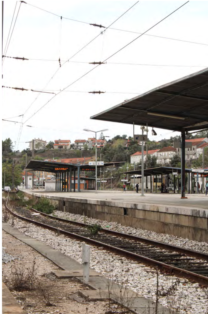
Figura 1 - Vista atual da Estação Coimbra B
