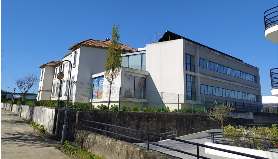
Figura 17: Pormenor volumétrico da união entre a Escola Primária e o Novo Edifício (fachadas nordeste e Nascente). Fotografia de autor.
