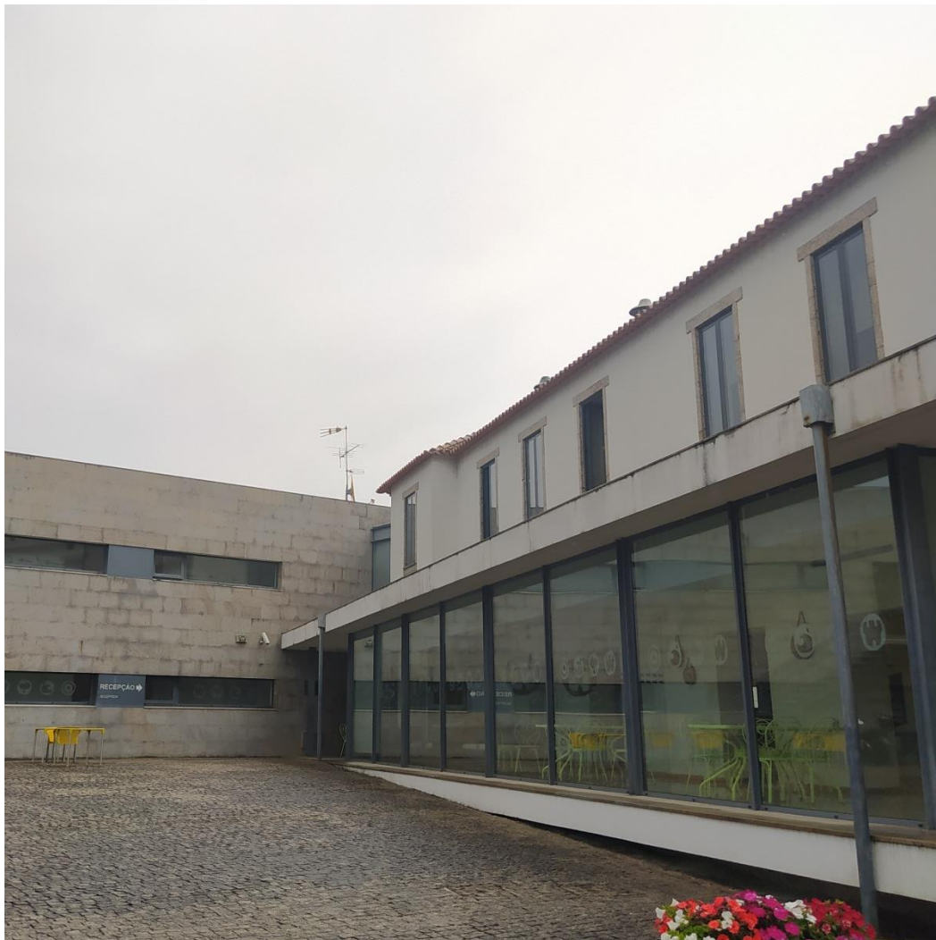
Figura 28: Módulo de vidro visto pelo exterior. Fotografia de autor
