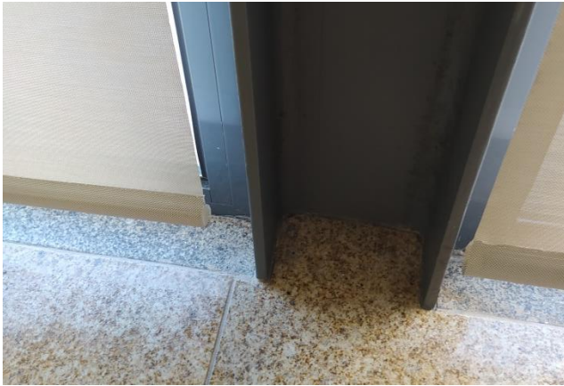
Figura 27: Pilar em ferro onde fixam os vãos da sala de apoio às refeições, do interior da sala. Fotografia de autor.
