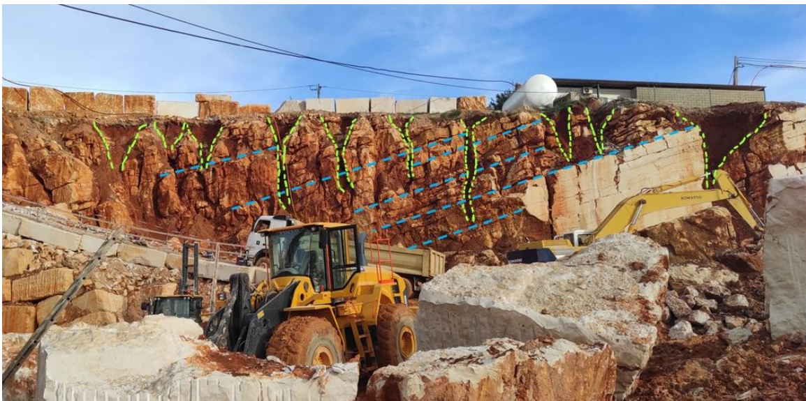
Figura 20 - Aspetos geral do talude em estudo. A azul está assinalada a estratificação e a verde os algares.
