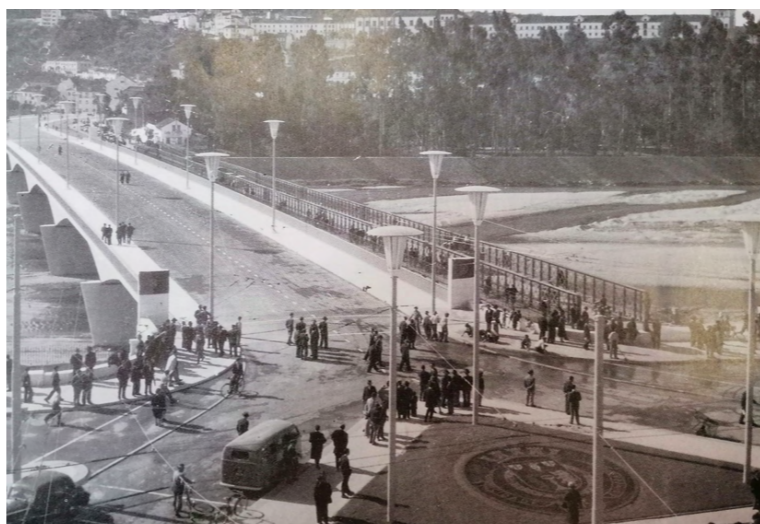
Fig.15- Inauguração da Ponte de Santa Clara 1954
