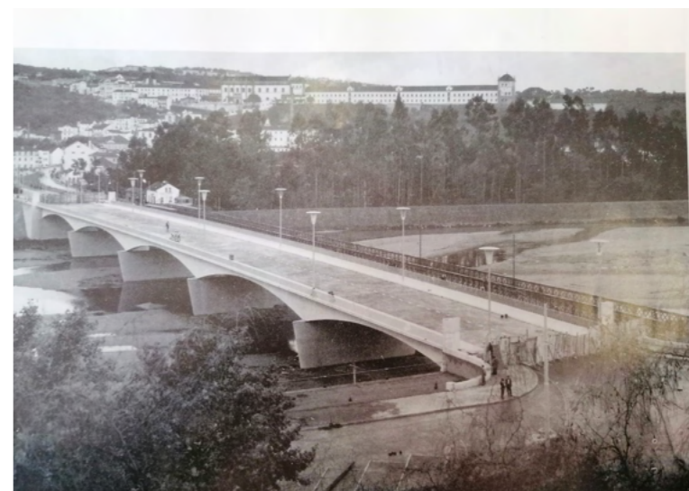
Fig.16- Inauguração da Ponte de Santa Clara 1954
