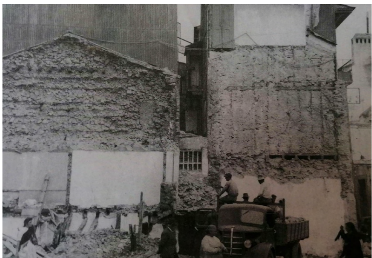
Fig.17- Demolição de edifícios para abertura da Avenida Fernão de Magalhães. Largo das Ameias, 1953
