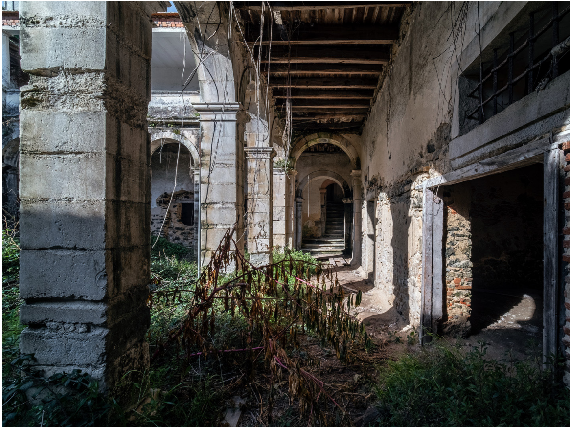
Img.32 Estrutura do claustro em madeira sobre arcos e pilares em pedra
