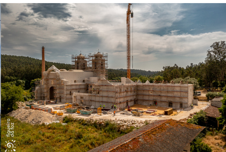
Img.54 Obra de reabilitação do Mosteiro de Seça - Junho de 2023
