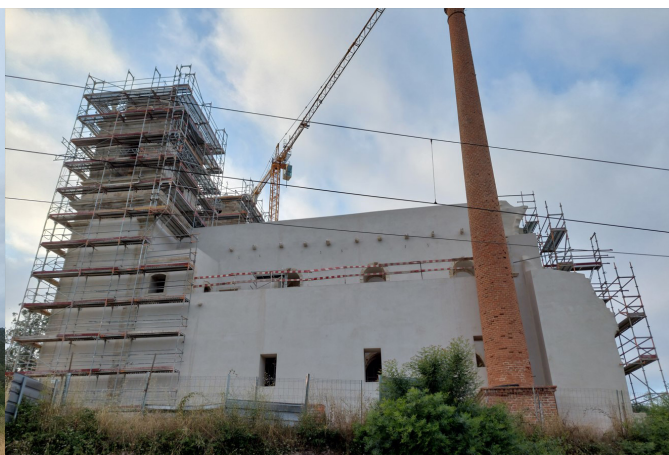
Img.56 Obra de reabilitação do Mosteiro de Seça - Junho de 2023
