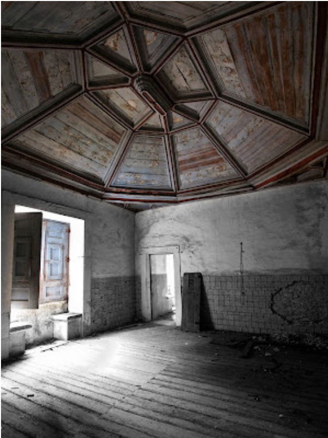
Img.31 Revestimento subsistente em madeira
