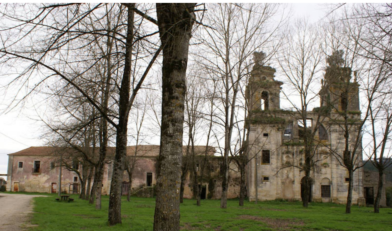
Img.43 Foto da envolvente antes da passagem do furacão Leslie
