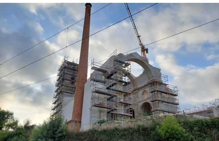
Img.53 Obra de reabilitação do Mosteiro de Seça - Junho de 2023
