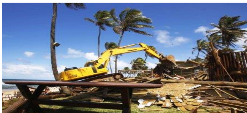
Figura 4 - Demolição de barracas de praia em Salvador/Bahia
