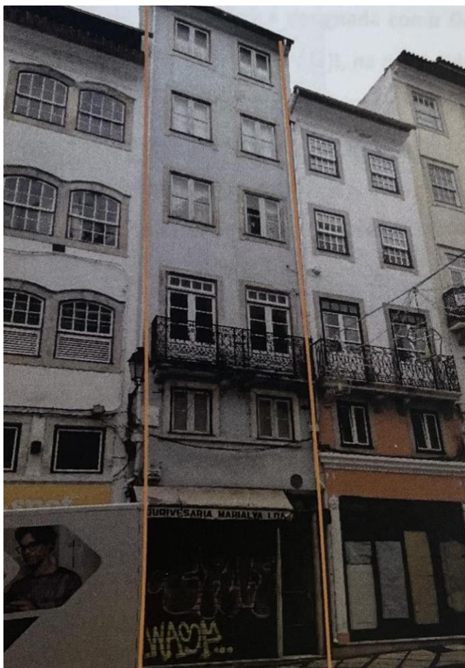
Figura C: Edifício do Mikveh , Rua Visconde da Luz, nº21, Coimbra.
