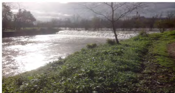
Fig. 67 - Sifão e a relação com o rio | Fig. 68 - Sifão e relação com o canal de rega Fig. 69 e 70 - Sifão e relação com acesso rodoviário | Fig. 71 - Descarregador fusível do Choupal
