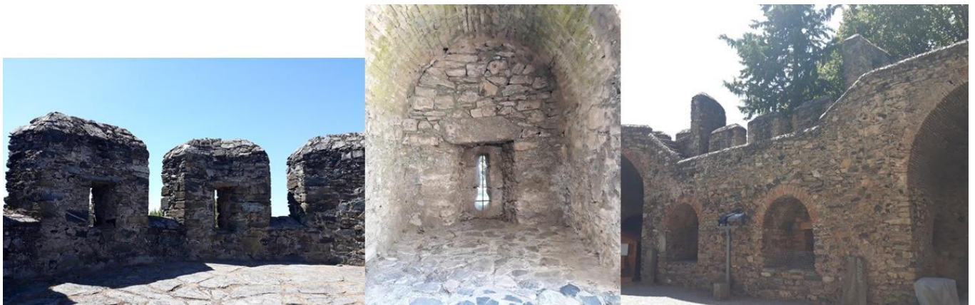
Fotografias da fortaleza de Bragança onde se destacam as seteiras nas ameias e as troneiras nos pequenos nichos (de construção provavelmente posterior).
