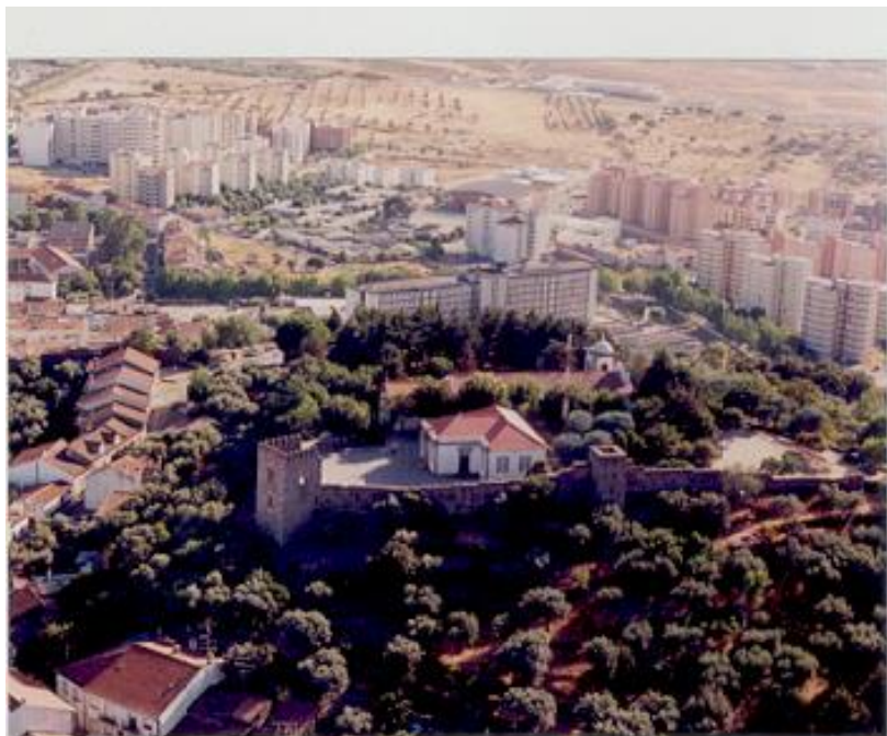
Fotografia aérea do centro de identidade de Castelo Branco (c.1990/2000)
