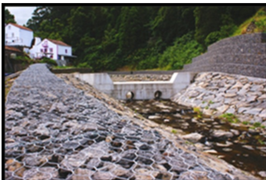
Figura 3.7 – Bacia de retenção na Vila da Aqualva, Açores
