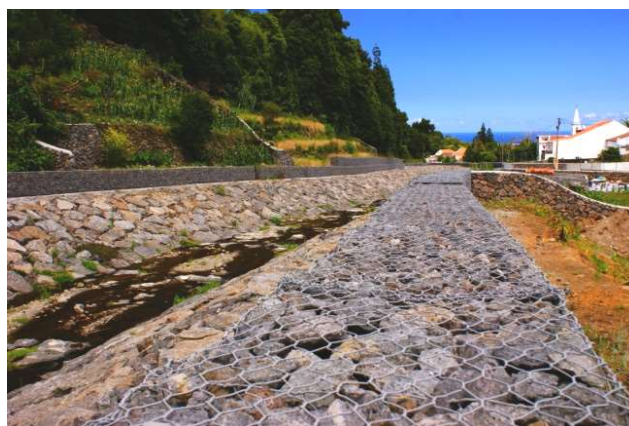
Figura 3.9 – Canal construído a jusante da bacia de retenção
