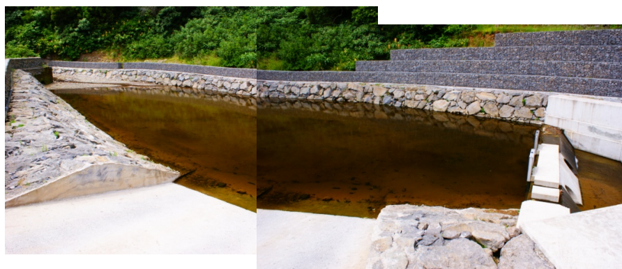
Figura 3.8 – Vista do interior da bacia e descarregador de emergência.
