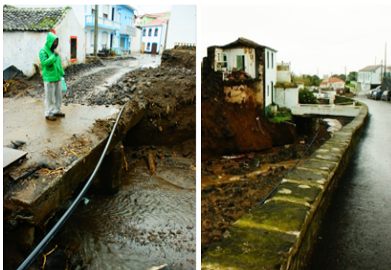
Figura 3.5 – Danos causados pela chuvada de 15 de Dezembro de 2009
