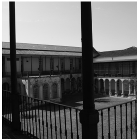
FIG. 37: Estado actual do Colégio das Artes
