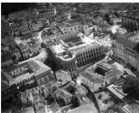
FIG. 34: Faculdade de Letras em construção, N.D. 1945?
