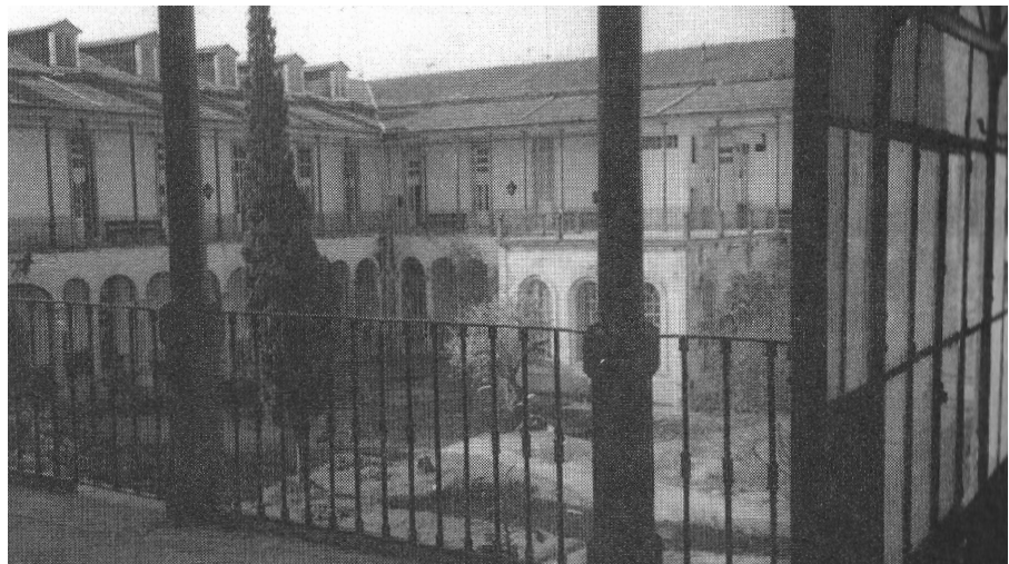
FIG. 23: Claustro do Hospital do Colégio das Artes, já com a cobertura instalada . 1930? Alberto Pessoa, Hospitais de Coimbra , 1931
