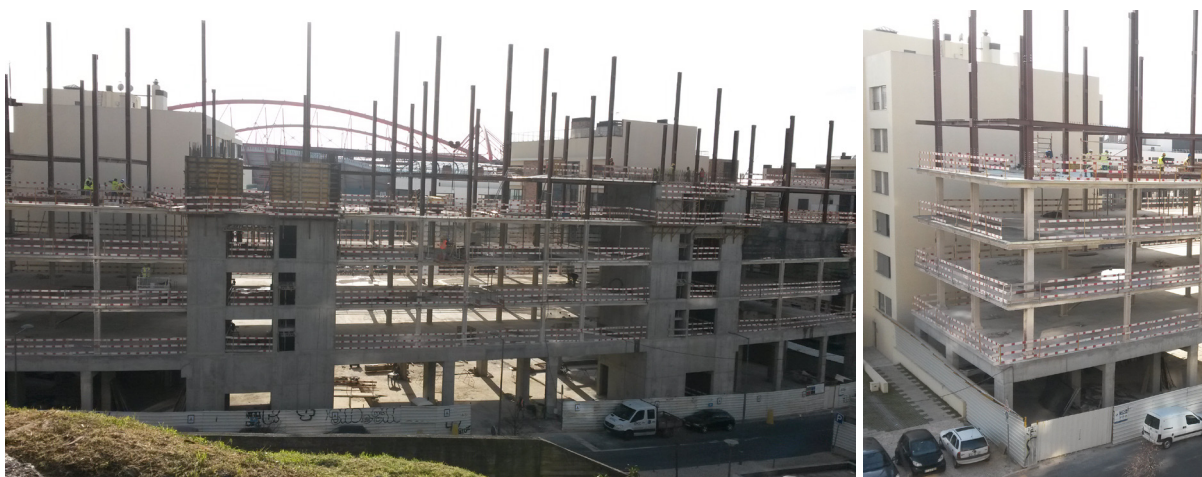
Figura 2.50 – Luxury Flats – Benfica Stadium , Lisboa. Aplicação de argamassas projetadas como sistema de proteção ao fogo (R90) (Metaloviana e SE2P, 2016).
