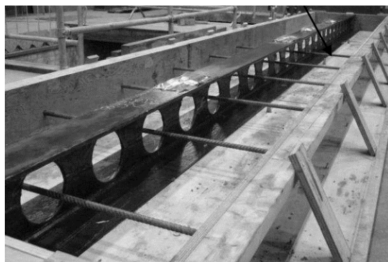
a) Slimfloor com vigas alveolares (Huo, 2012).
