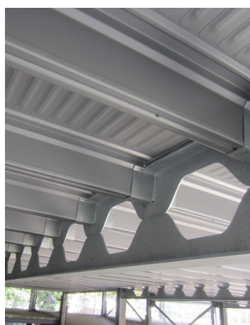
b) Angelina Beam – Arcelor-Mittal ; chapa colaborante de grande altura ( Constructalia , 2016a).
