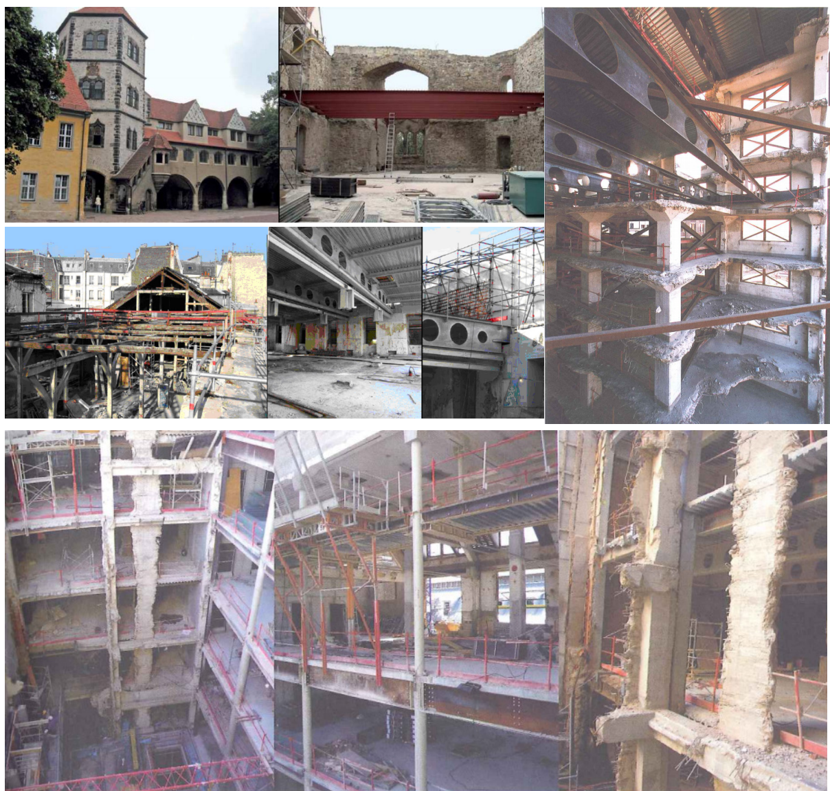
Figura 2.44 – Exemplos de reabilitação de estruturas com introdução de elementos estruturais mistos aço-betão (Engel, 2010).
