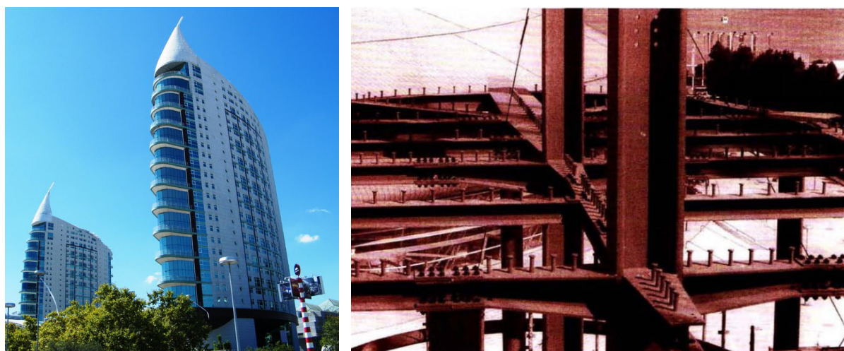
Figura 2.42 – Torres de São Gabriel/São Rafael, Parque das Nações, Lisboa (Calado e Santos, 2011; Panoramio, 2016).
