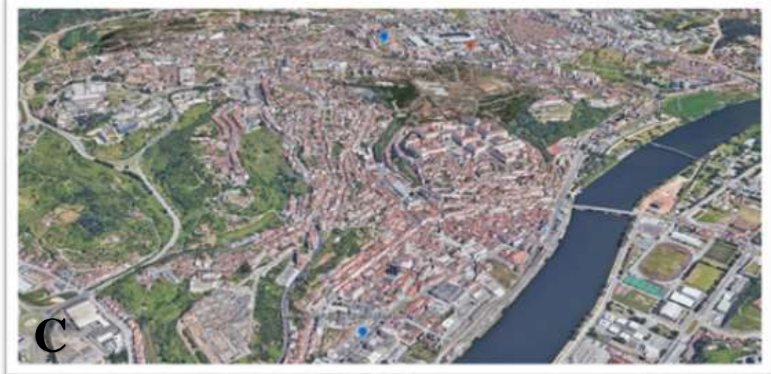
Fotografia 3- A- Instituto Geofísico da Universidade de Coimbra; B- Avenida Fernão de Magalhães; C- Área envolvente dos medidores de poluição
