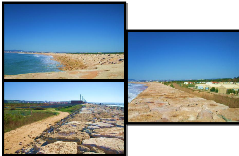
Figura 4.21- Fotografias da estrutura aderente de defesa costeira retiradas no local.
