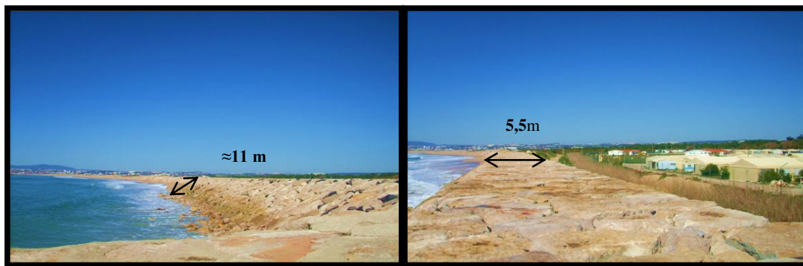
Figura 4.22- Estrutura aderente de defesa costeira com representação das medidas do comprimento do talude e da largura da berma.
