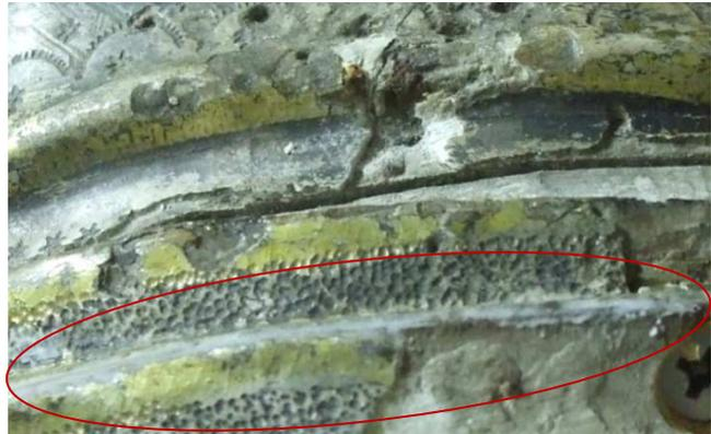
**Fig.52. Pormenor da fixação com resina acrílica e micro-esferas de vidro para preenchimento dos espaços vazios.**
