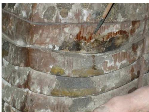
**Fig.49. Fixação com resina acrílica**
