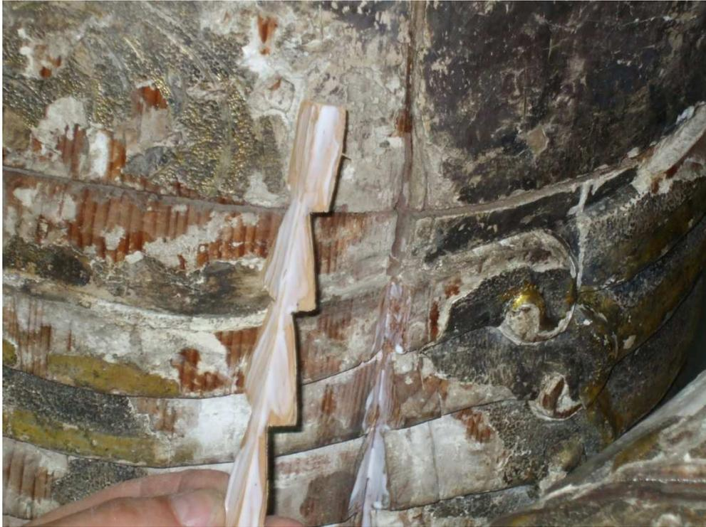
**Fig.77.** Nesta figura observamos a fase de colagem de um elemento novo para preenchimento e reforço do lado esquerdo do corpo da escultura.
