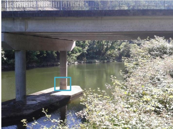
Figura 4.13 – Pilares de suporte da ponte de Rebordosa com marcas de identificação do nível médio das águas durante as estações mais frias (Fotografia do autor, junho de 2013).
