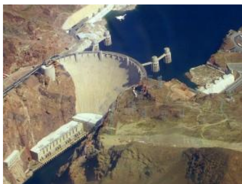
Figura 2.8 – Barragem de Hoover, Estados Unidos (inforescola.pt)
