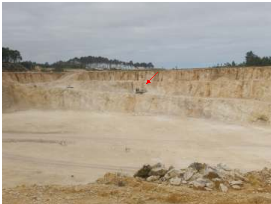
Figura IV.9 – Aspeto geral da Pedreira de Alva de Pataias com máquina perfuradora em atividade.
