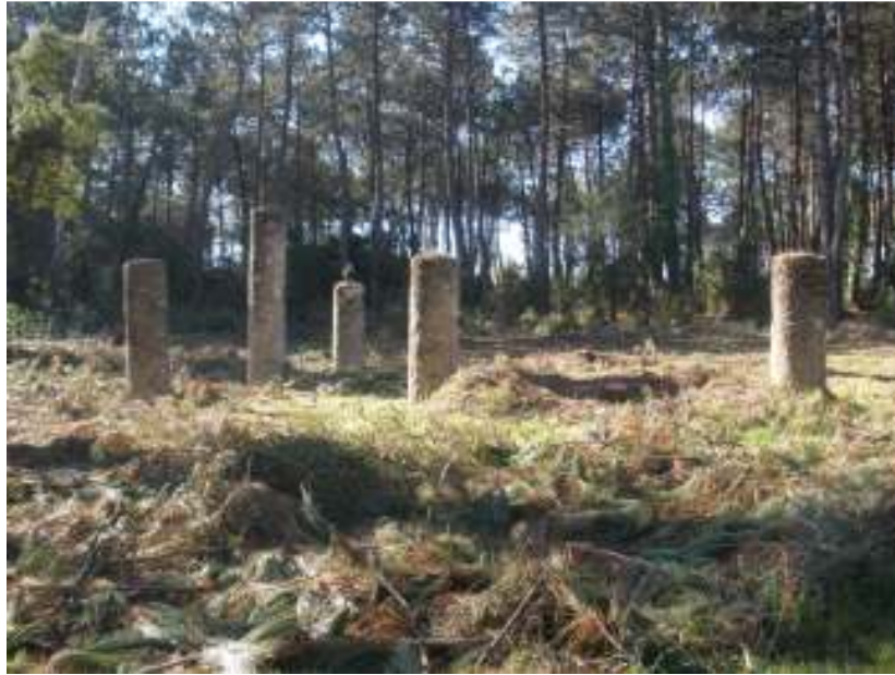
Figura III.2 – Pilares de sustentação de estrutura de apoio a Forno de cal junto da Fábrica de Cimento da CIBRA em Pataias.
