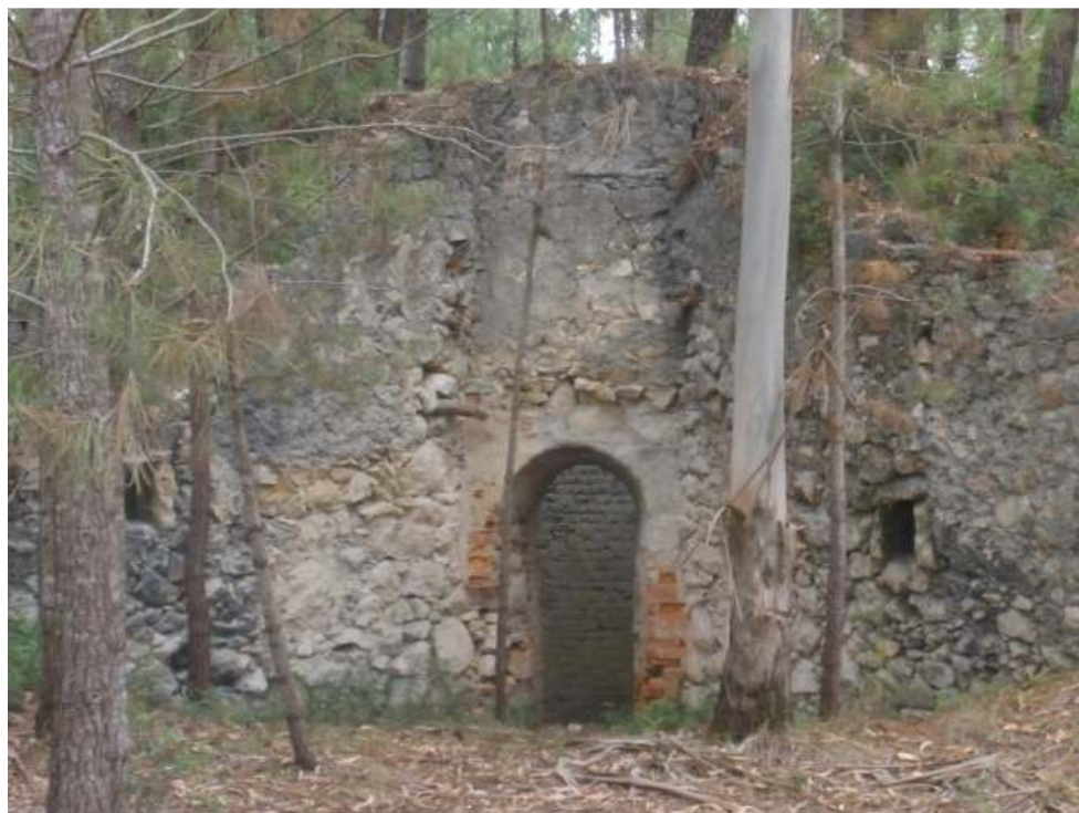
Figura III.1 – Ruína de Forno de cal junto da Fábrica de Cimento da CIBRA em Pataias.
