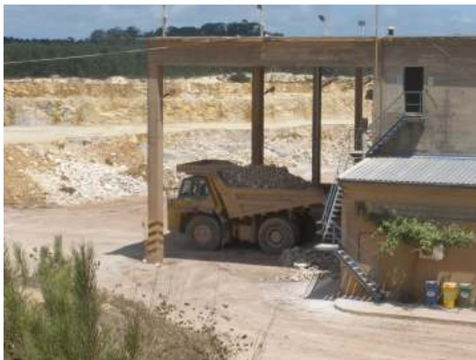
Figura IV.10 – Pormenor de camião de transporte de matéria-prima a descarregar no britador.
