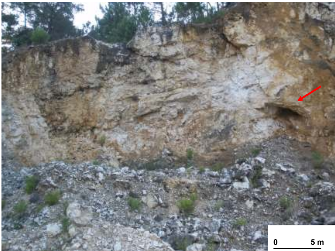
Figura V.4 – Aspeto da frente de desmonte (frente Noroeste – Ponto 22), com ausência de superfícies de estratificação e zona intensamente carsificada.
