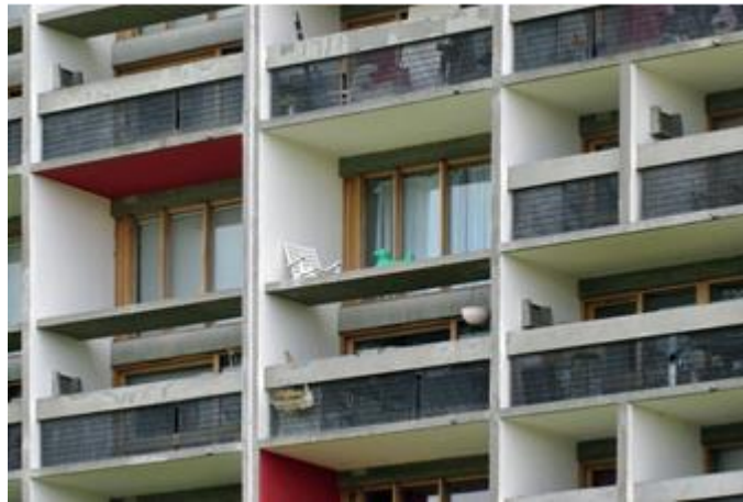
Figura 72: Mecanismo brise-soleil na fachada da Unité d'Habitation de Berlin
