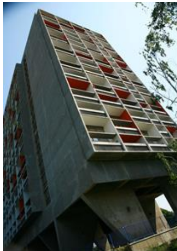
Figura 147: Vista do topo Sul da fachada da Unité d'Habitation de Firminy
