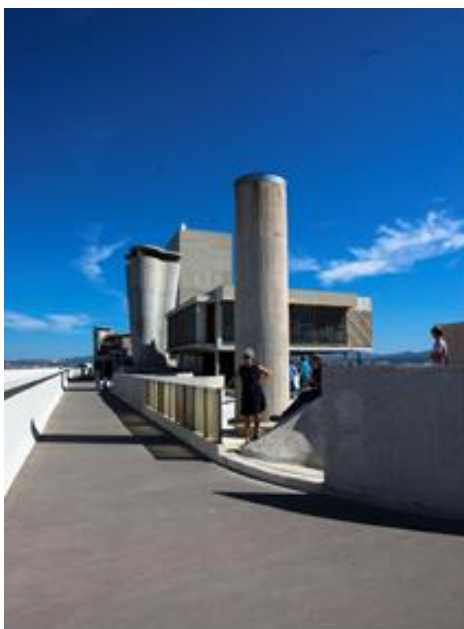
Figura 114: Vista do terraço da Unité d'Habitation de Marseille
