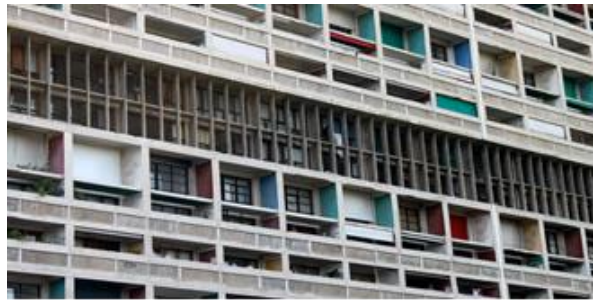
Figura 86: Vista exterior da rua comercial na fachada da Unité d'Habitation de Marselha
