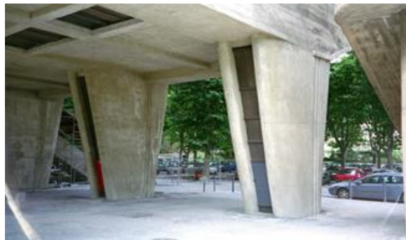
Figura 80: Vista dos pilotis na base da Unité d'Habitation de Marselha
