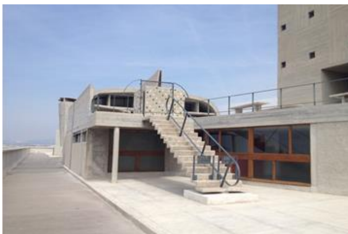
Figura 115: Vista do terraço da Unité d'Habitation de Marseille
