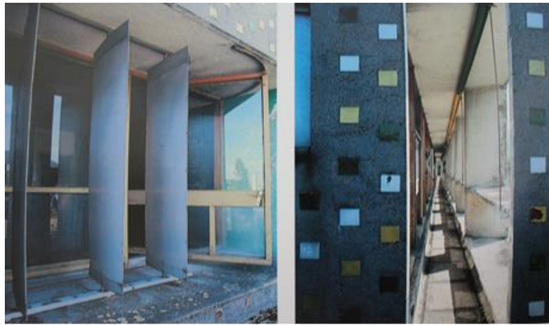
Figura 64: Mecanismo de sombreamento brise-soleil na fachada do edifício Manufactura Duval
