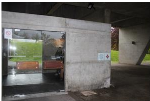
Figura 135: Vista do hall de entrada e seu contacto exterior com a base da composição
