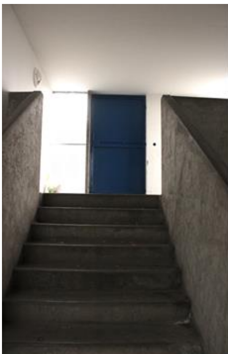
Figura 157: Vista interior da caixa de escadas para a porta de acesso à zona do terraço
