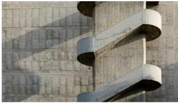
Figura 140: Vista da escada de acesso lateral exterior na fachada Norte
