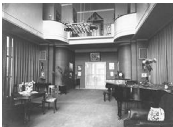
Figura 40: Vista da sala central da Villa Schowb
