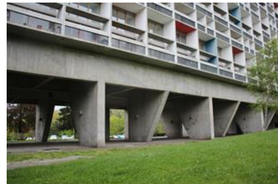
Figuras 129: Vista dos pilotis na base da Unité d'Habitation de Firminy
