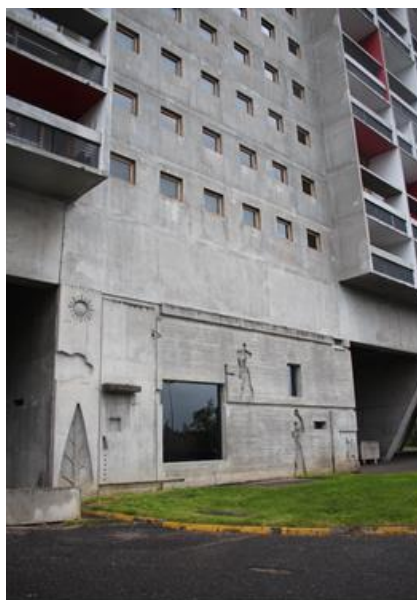
Figura 134: Vista exterior da fachada Este na zona da torre de elevadores
