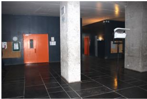
Figura 138: Vista interior do hall de entrada para o acesso à caixa de escadas
