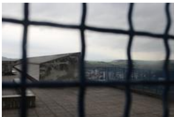
Figura 159: Vista para a zona exterior do terraço da Unité de Firminy
