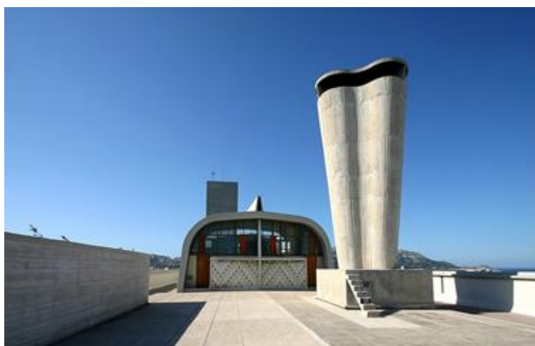
Figura 116: Vista do terraço da Unité d'Habitation de Marseille e alguns equipamentos
