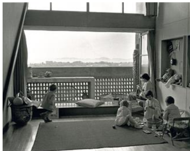
Figura 113: Vista interior da sala de pé-direito duplo para a varanda na fachada
