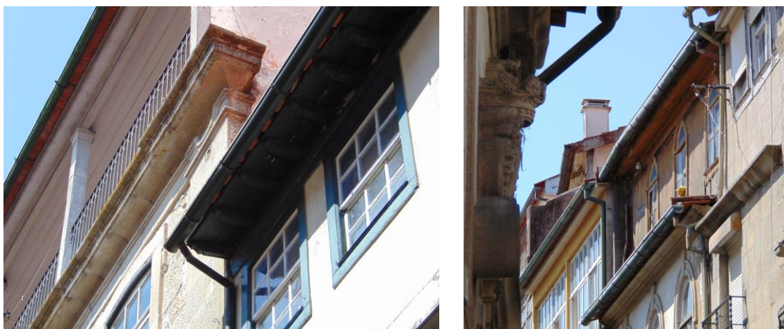
Fig. 2 – Piso recuado sobre cornija e beirado forrado sobre caibros. Piso recuado sobre cobertura. Fonte: elaborada pelo autor.
