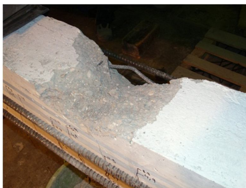
Figura 4.7 – Rotura da Viga 3.
