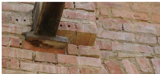
Figura 5.2 – Esmagamento de parede em zona localizada onde existe aplicação de cargas concentradas. Antiga Fábrica de Cerâmica Arganilense, Arganil.
