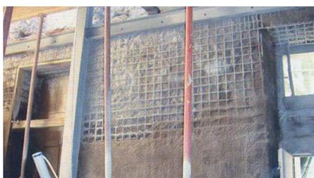
Figura 6.1- Aplicação de armadura e projecção de argamassa para consolidação e reforço de parede de alvenaria (INH e LNEC, 2006)
