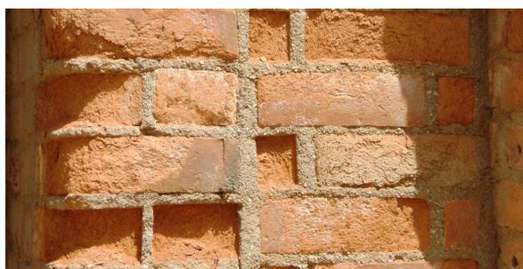
Figura 5.4 – Desagregação em parede de tijolo cerâmico. Antiga Fábrica de Cerâmica Arganilense, Arganil
