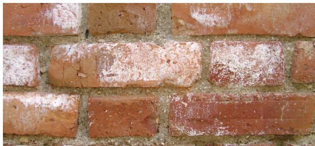
Figura 5.3 – Eflorescências em parede antiga de tijolo cerâmico. Antiga Fábrica de Cerâmica Arganilense, Arganil.
